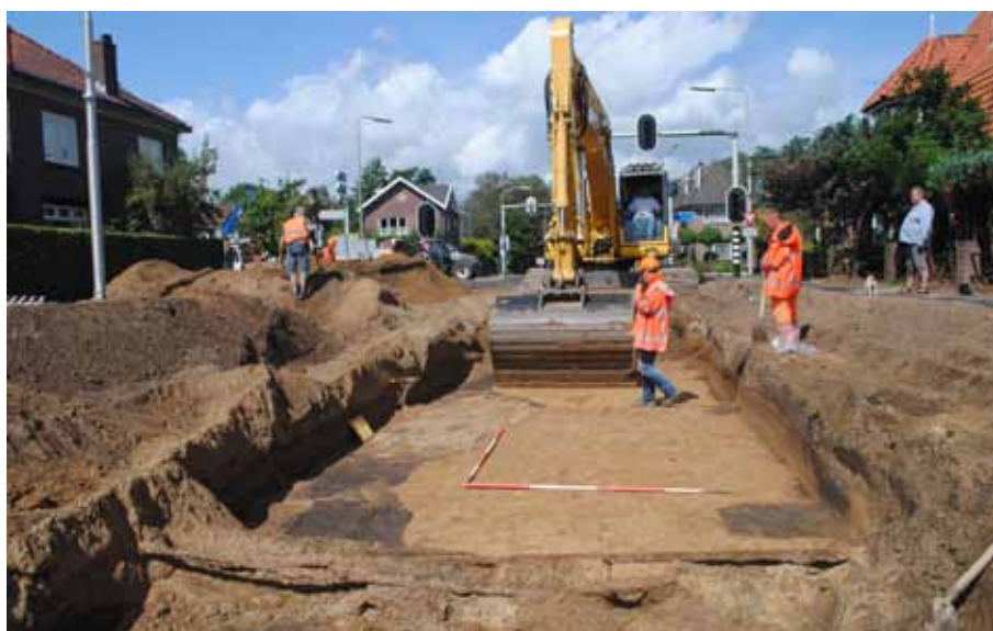
3. Opgravingsvlak in de Van der Capellenlaan t.h.v. de Deventerweg.
