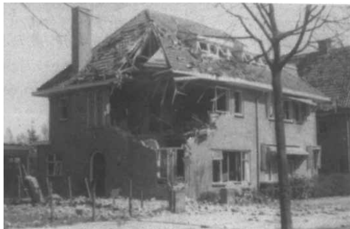
9. Huis aan de Van der Capellenlaan na de beschietingen op 7 april 1945.
