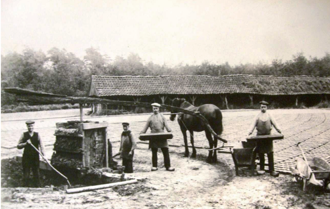
Figuur 13. De steenbakkerij van Te Winkel in Miste in 1913. Links bevindt zich de leemkuip met de door een paard aangedreven leemmolen. Achter de mannen met de steenvormen liggen vormen te drogen op het droogplein (steenplas). Op de achtergrond staan de droogloodsen.
