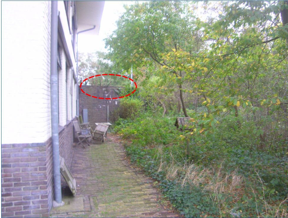
Figuur 4. Situatie aan de zuidzijde van het pand met de terras-/steilrand.
