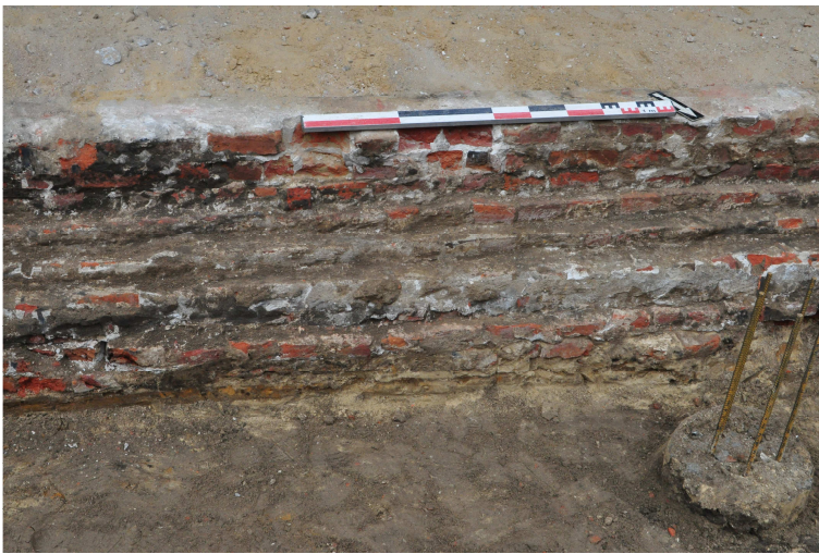
Figuur 3. Muur S1 en S2, duidelijk verschillend van aard.
