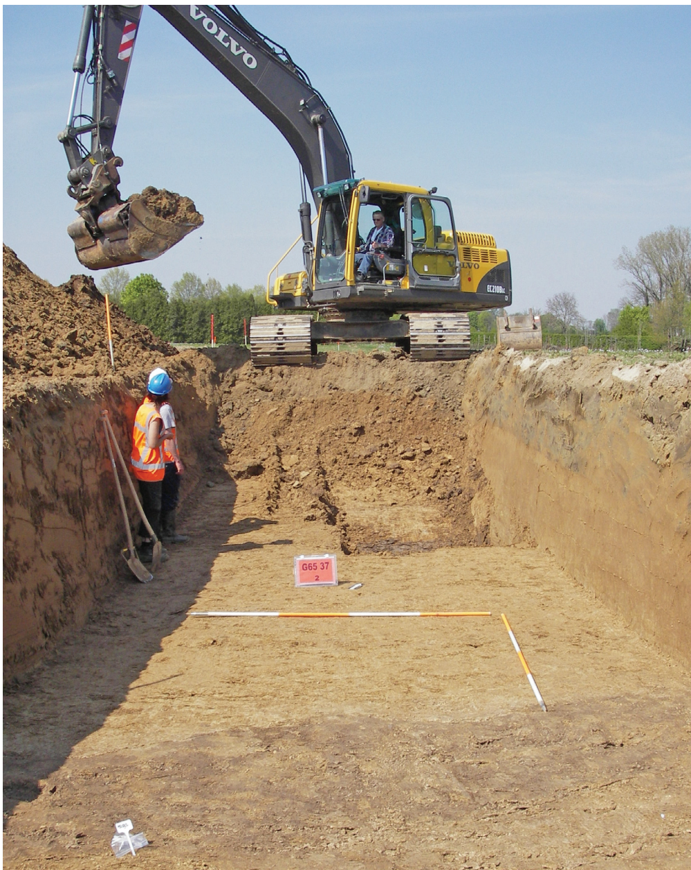
Figuur 3. Aanleg WP1, vlak 1.
