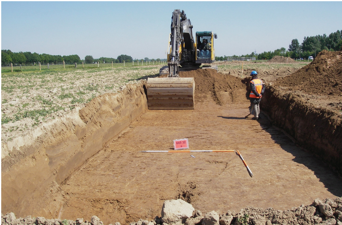
Figuur 4. Aanleg WP3, vlak 1.
