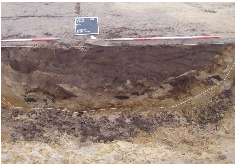
Afb. 6.52 Doorsnede door kuil ter hoogte van de knik in structuur 1005 waarbij zichtbaar is dat de greppel (S20019) wordt oversneden door de kuil (boven). De kuil zelf heeft verschillende opvullingslagen (onder) en is mogelijk meerdere keren uitgegraven.
