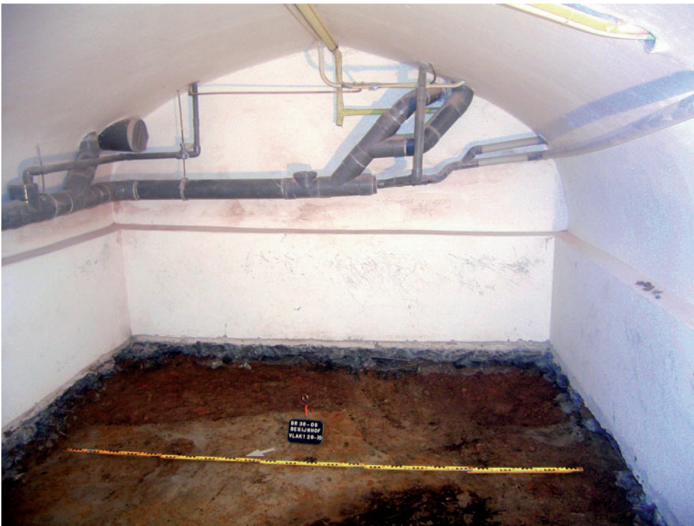
Fig. 4 Fundament S1 dat schuin ten opzichte van de achterwand loopt.
