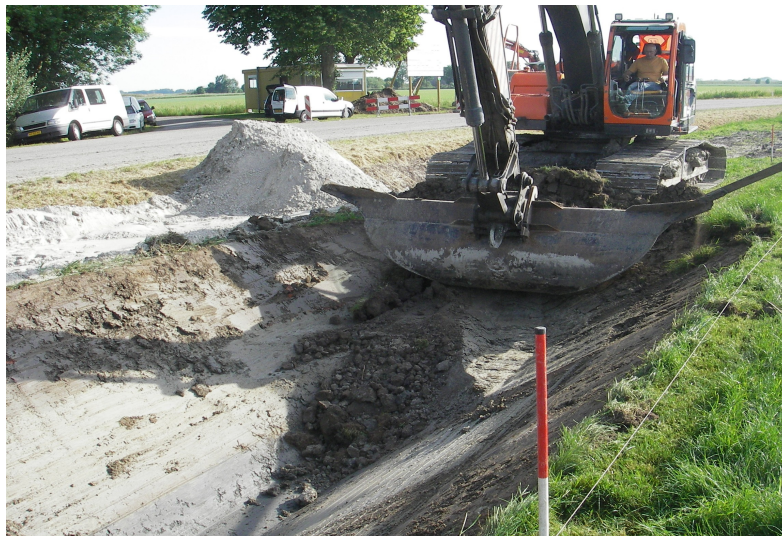
Figuur 2: Fietspad Oldehove-Aalsum. Het uitgraven van de sloot.
