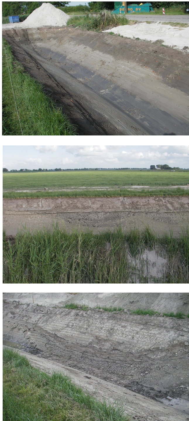
Figuur 3: Fietspad Oldehove-Aalsum: foto's van de naast het fietspad gelegen nieuw uitgegraven sloot. Foto boven, richting zuidwest, overzicht nieuwe sloot; foto midden, richting zuid, doorsnede van twee oude sloten; foto onder, richting noordwest, doorsnede van oude geul.
