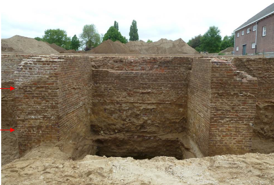
4 Tweede vak van de zuidelijke face: drie pakketten metselwerk verraden de werkvolgorde. De eerste bouwfase die in twee campagnes is voltooid en de tweede bouwfase.
