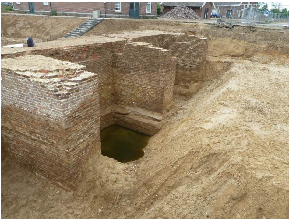
23 De basis van de steunberen van de zuidelijke face is flink breder dan het opgaande werk.
