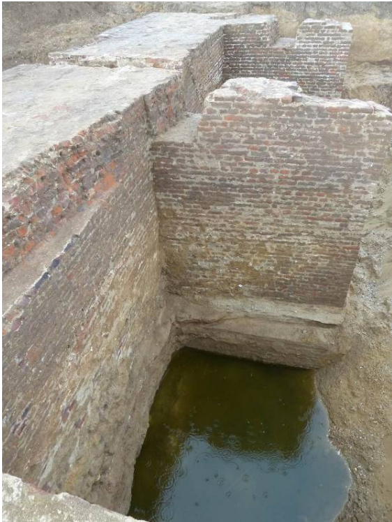
24 Boven de brede voet lopen de steunberen van de zuidflank taps toe.
