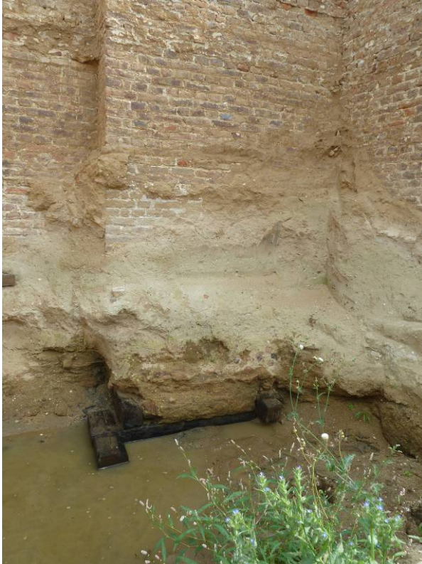
8 Het buiten de muur uitstekende balkenrooster van de fundering bij de tweede verspringing in de oostelijke face.
