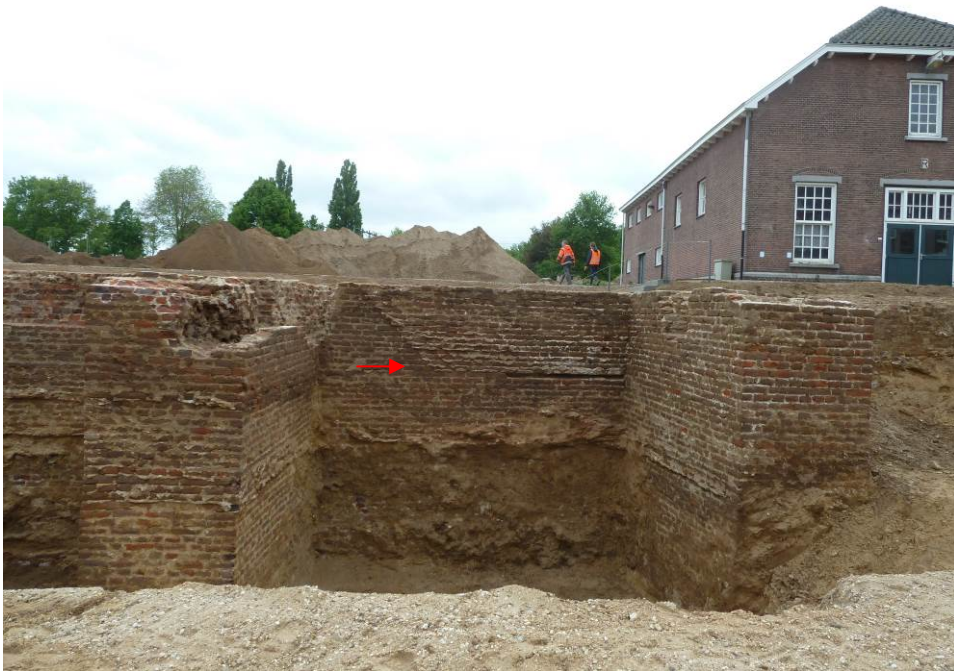
3 Derde vak van de zuidelijke face met boven de sleuf een slordig gemetselde aanvulling met vallende tand. Het betreft de overgang van de eerste en tweede bouwfase.
