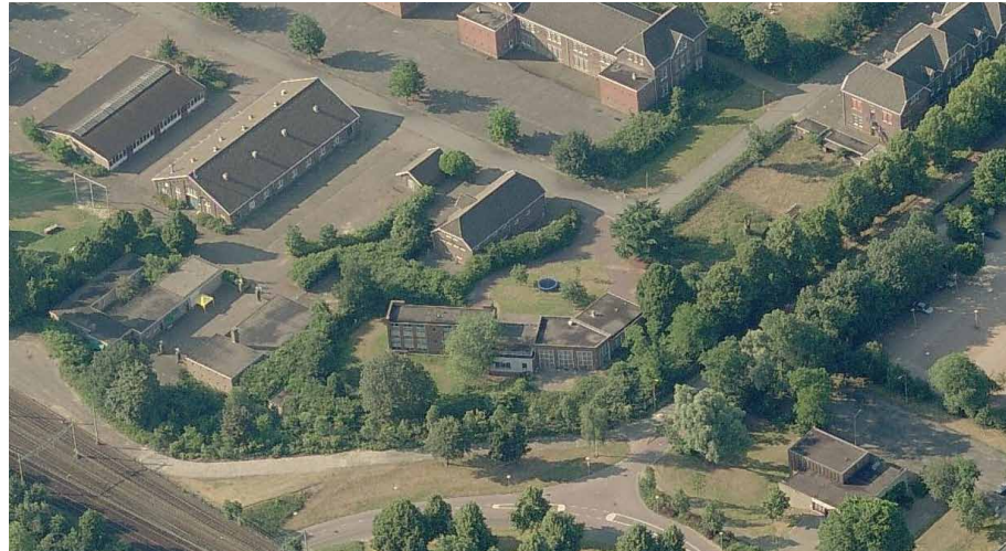
Afb. 7.36 Luchtfoto van het terrein voor de afbraak van de officiersmess ( http://www.bing.com ).
