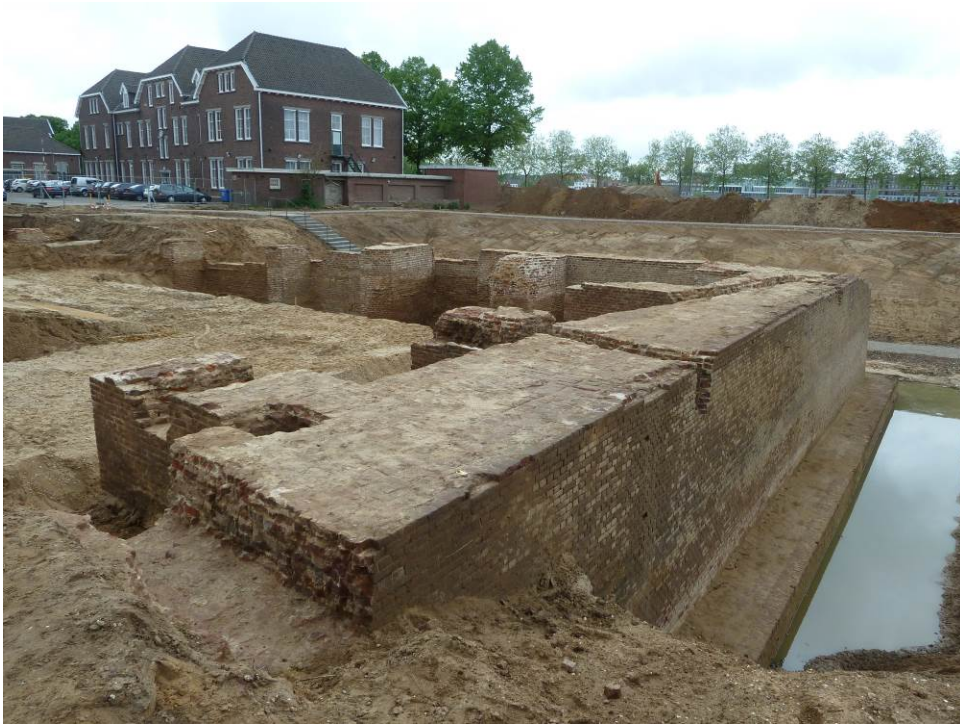
2 Overzicht van de bastionpunt met de herstelde klampmuur.
