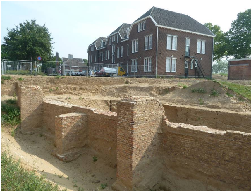
9 Vervolg binnenzijde oostelijke face, de steunbeer in het midden is nooit hoger geweest. Daar strak overheen loopt een specierand die ook in de andere vakken te volgen is.
