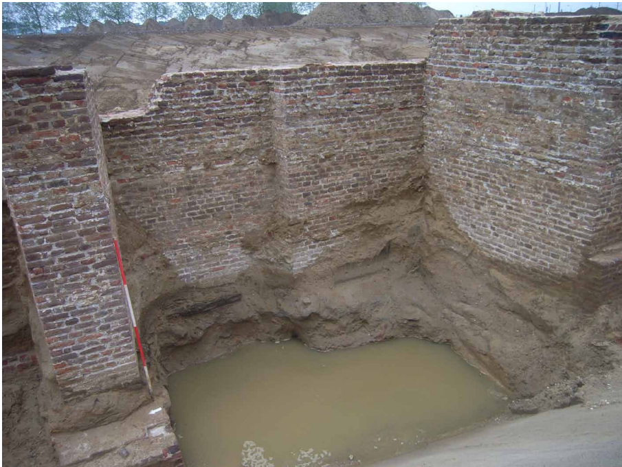
Afb. 7.19 De fortzijde van de oostelijke face, tussen steunberen S74004 en S74006. Foto genomen richting het zuidoosten.
