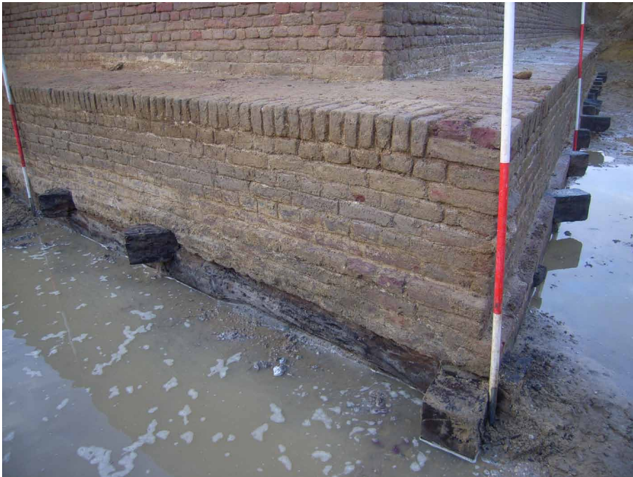
Afb. 7.17 De houtfundering en voet van het fort, ter hoogte van de saillant. Foto genomen richting het noorden.
