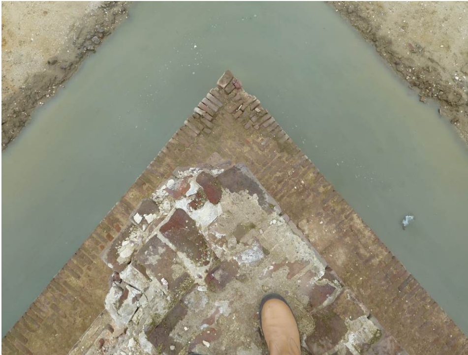
16 De punt van het bastion met de bredere funderingsvoet.
