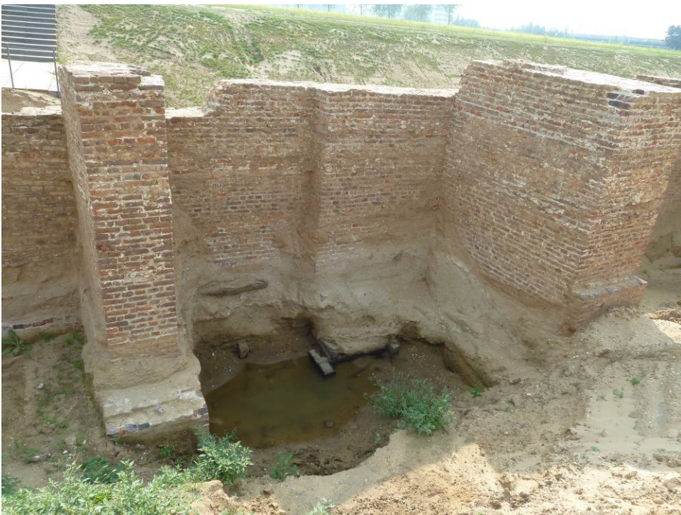
7 Derde vak van de oostflank met wederom een versmalling van de schildmuur en groot verschil in steunberen. Het zichtbare balkenrooster ligt onder de positie van de verdwenen secundaire steunbeer.
