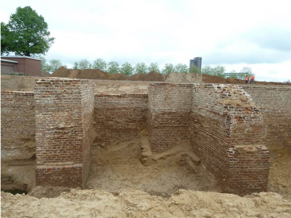
6 Het tweede vak van de oostelijke face met een forse verspringing in de schildmuur.
