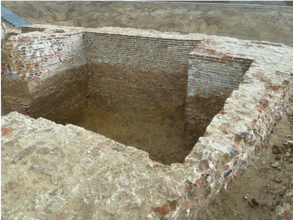
20 In het bovenste muurwerk van de bastionpunt is het metselwerk (bouwphase twee) slordiger uitgevoerd en is een harde, witte mortel gebruikt.
