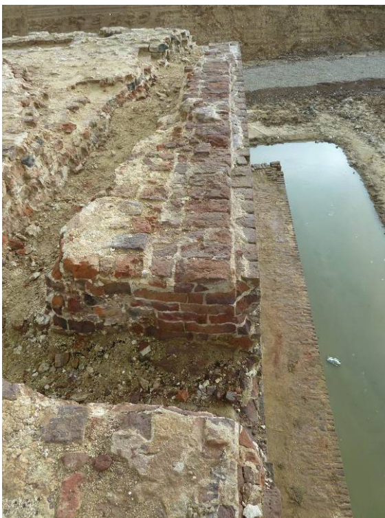
19 Dichter naar de punt wordt de klamp ca. een halve meter dik.
