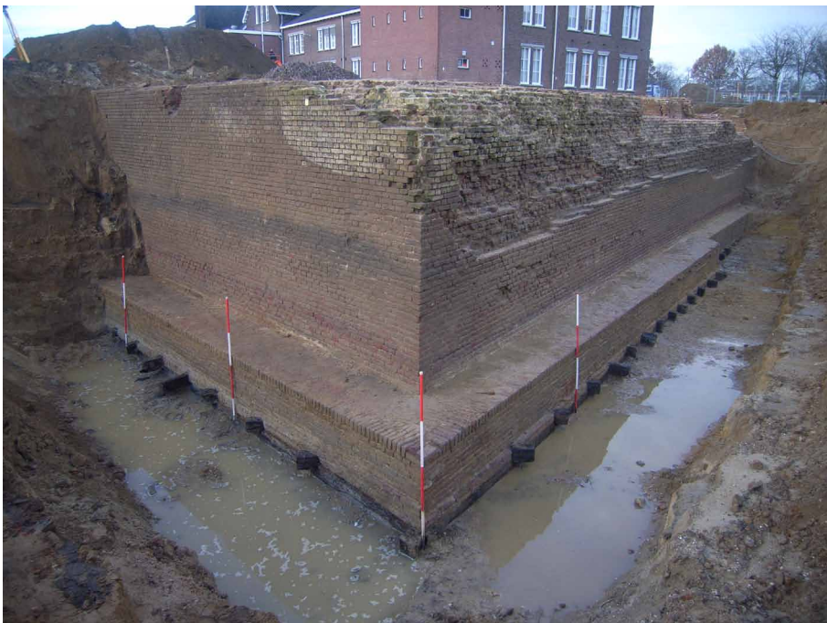
Afb. 7.18 De saillant van het zuidoostelijke bastion met de aangrenzende facen. Foto genomen richting het noordwesten.
