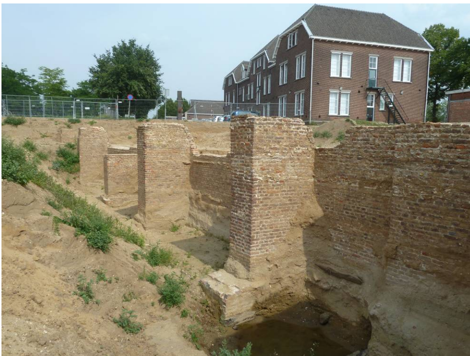
21 Bij de eerste kleine steunberen is het verschil tussen aanleg en opbouw groot, mogelijk vanwege een planwijziging tijdens de uitvoering.
