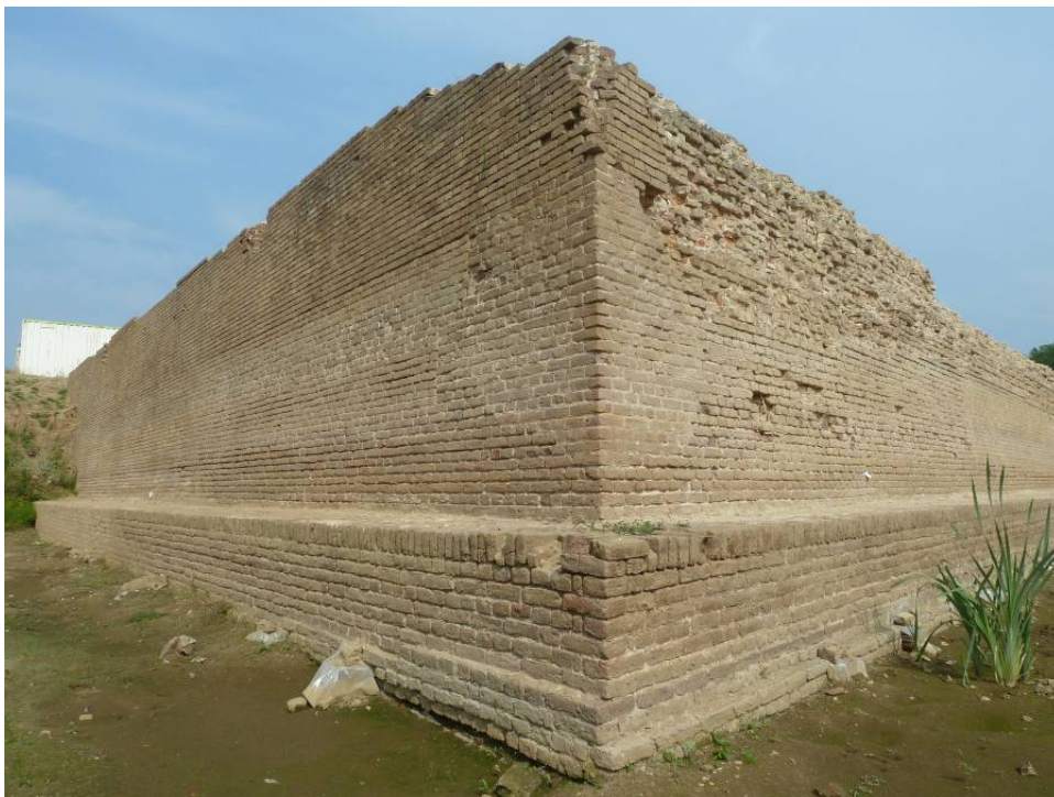
13 De bastionpunt met links van de punt de diverse verticale bouwnaden van het aansluiten van verschillende metselploegen en rechts de deels verweerde oostflank
