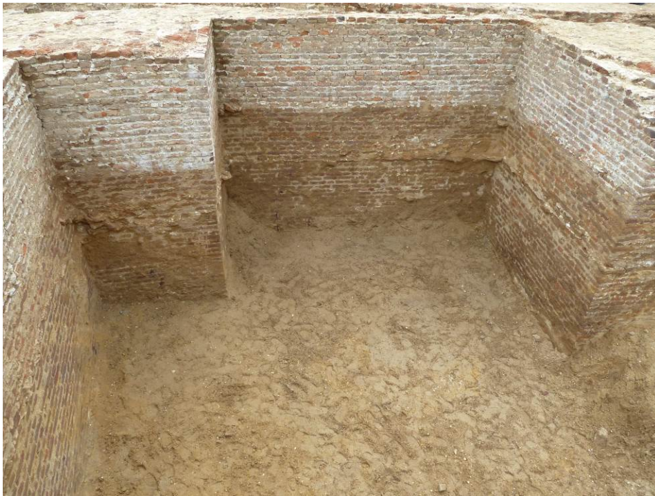
22 De eerste metselronde en het aanvullen met zand in de eerste bouwfase wordt gemarkeerd door een dikke mortelrand.
