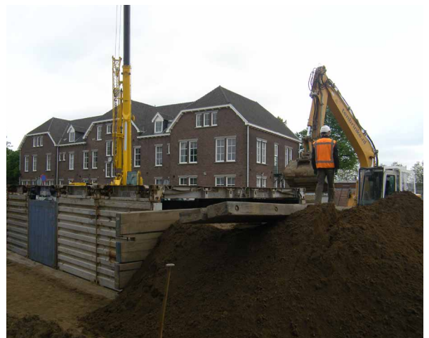
Afb. 7.51a-d De diverse bouwstadia van de beschermende constructie rondom de bommen.
