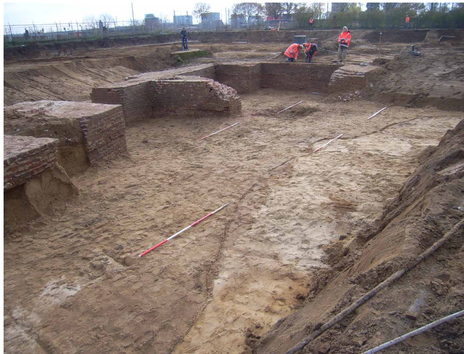
Afb. 7.16 De insteek van het muurwerk van het fort, ingegraven in de natuurlijke ondergrond. Foto genomen richting het zuidoosten.
