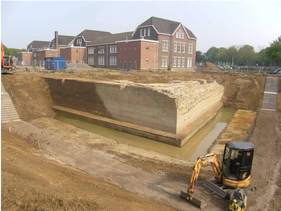
Afb. 7.15a Overzichtsfoto van het bastion met recent aangelegd wandelpad.
