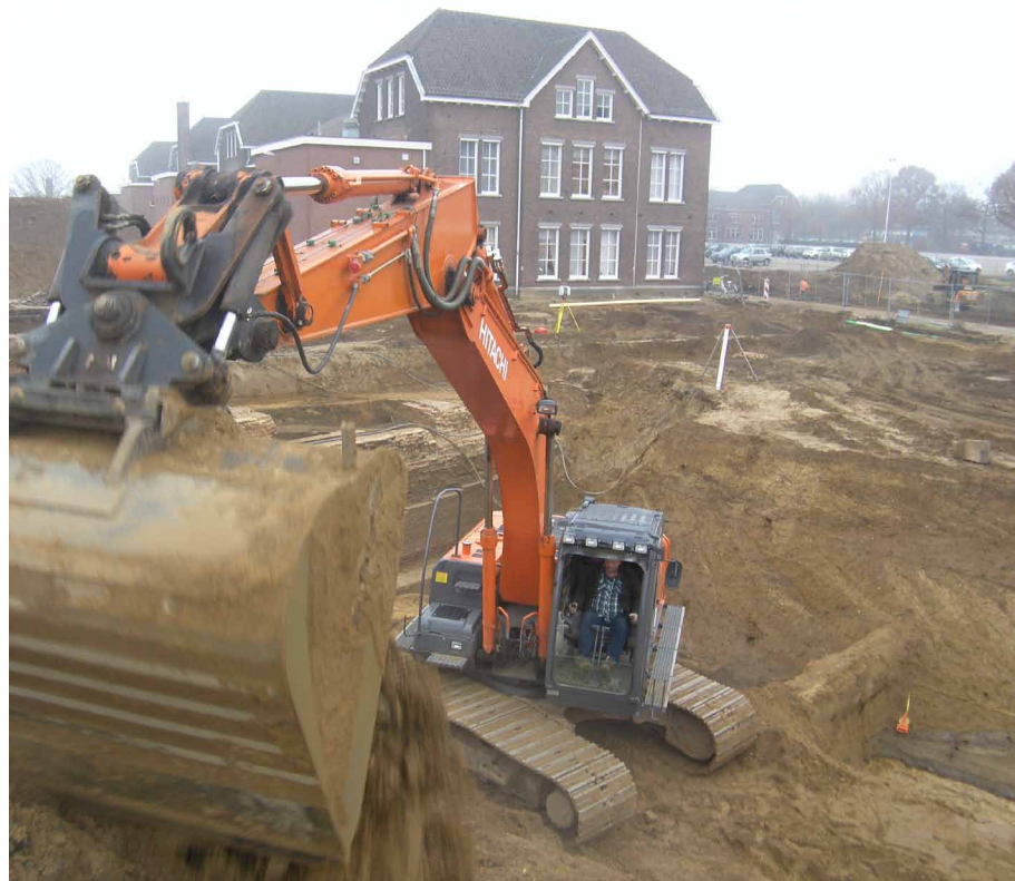
Afb. 6.3 Archeologische graafwerkzaamheden nabij de muren van het fort.
