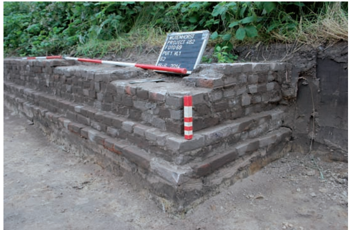
Afb. 5.19: Funderingsmuur van een schuur, structuur 11.
