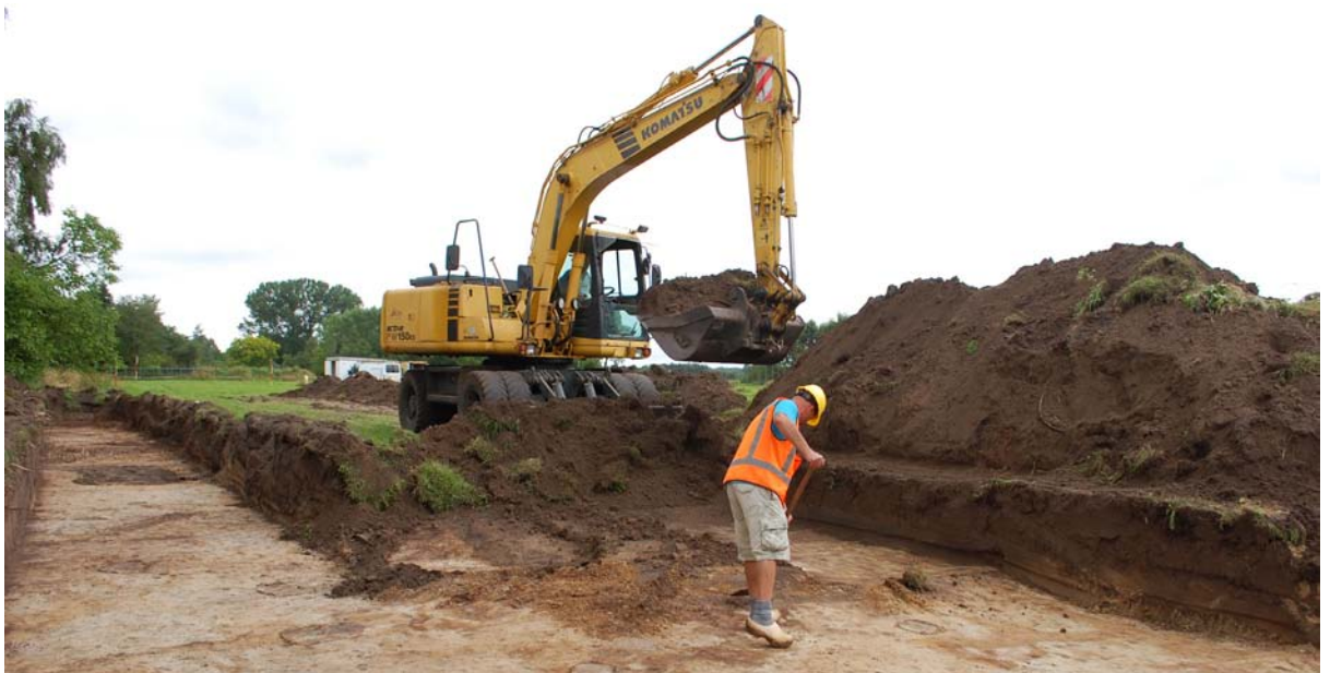
Afb. 3.2: De aanleg van werkput 1.
