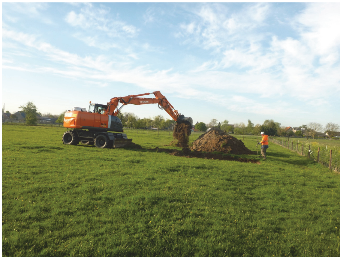
Fig. 4.1: De aanleg van het vlak in werkput 1.
