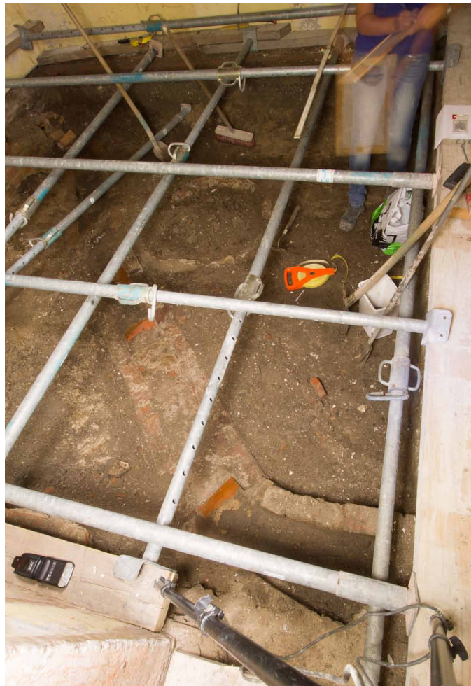
Afb. 2.5 Opname van de werkzaamheden in de kelder.
