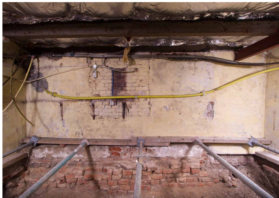
Afb. 3.10 Aanzicht van de zuidelijk keldermuur, deel van de rechterzijgevel. De muur is gefundeerd op ouder muurwerk, opgetrokken met kloostermoppen (13-15 x 6,5-7 x 30 cm). Uiterst rechts een dichtgezette deuropening, links daarvan een dichtgezet kelderlicht. Metselwerk daartussen is vermoedelijk beklampt.
