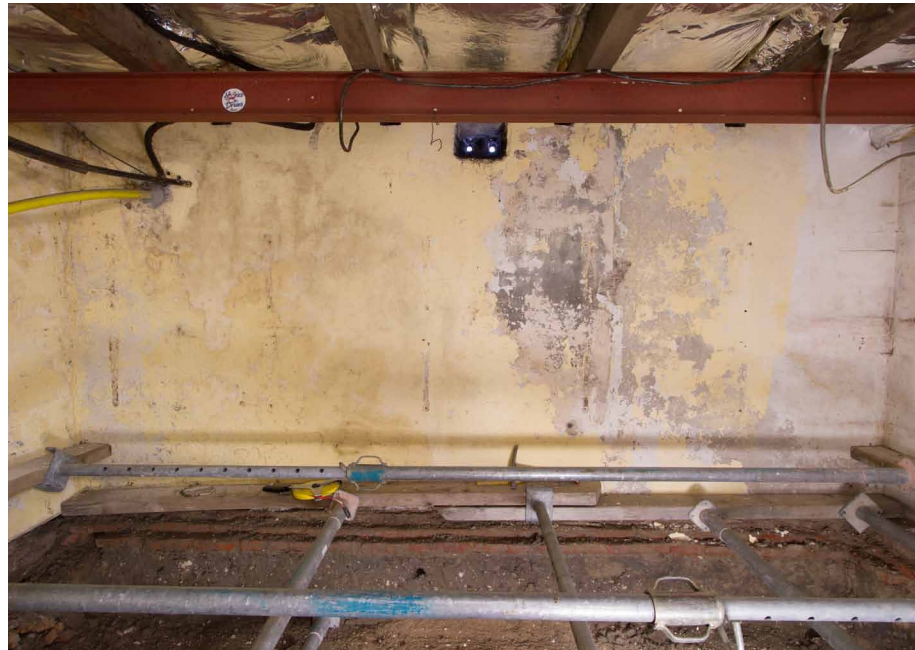
Afb. 3.9 Aanzicht van de westelijke keldermuur, deel van de voorgevel, geheel 19e-eeuws en met centraal een ventilatieopening.
