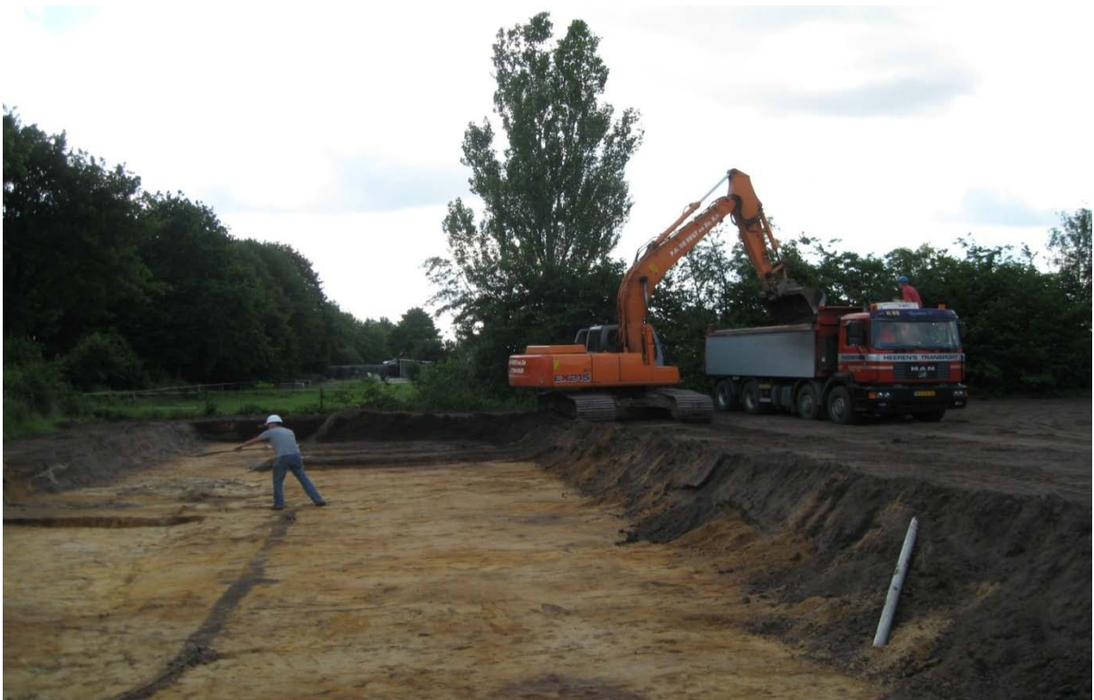
Afbeelding 2: aanleg van het vlak in banen en transport van de grond.
