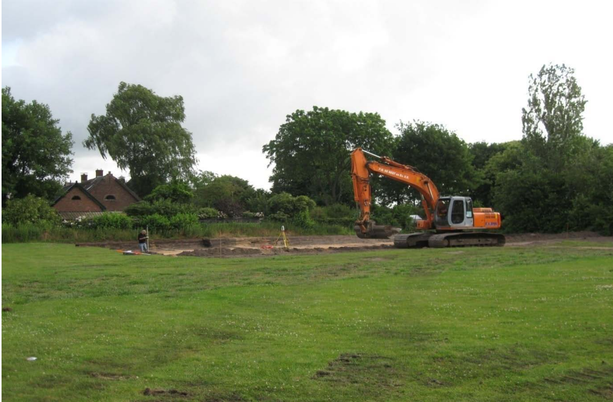
Afbeelding 3: sfeerfoto van de werkzaamheden.
