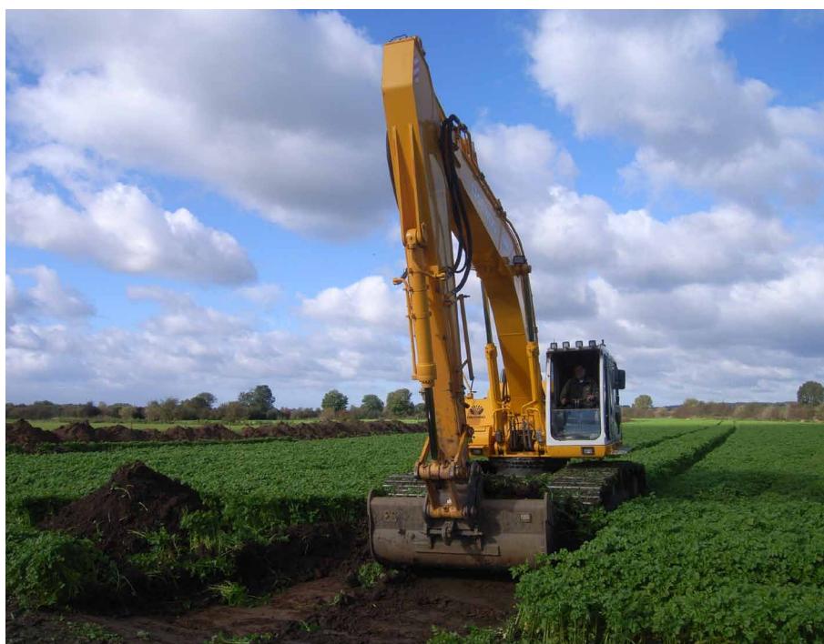
Afbeelding 4.01. Overzicht van de aanleg van werkput 10 (fotonr. R0012666, d.d. 25.10.2010).
