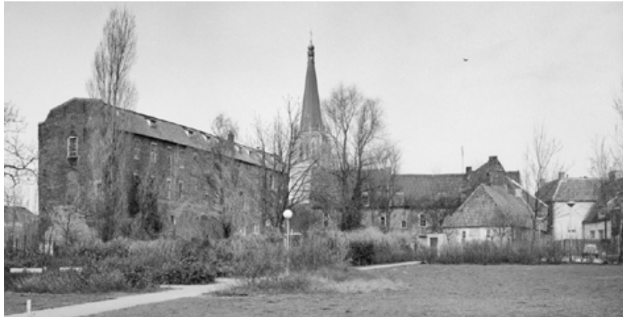
8. De achterkant van het Groote Convent in 1984. De bebouwing aan de rechterkant dateert van rond 1400. Op de achtergrond de St. Martinuskerk.
