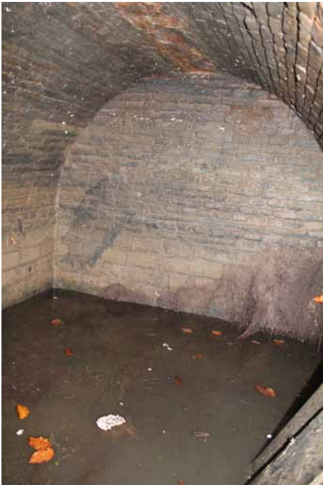
14. Het interieur van de tongewelfde waterkelder. Op de bodem staat nog een laag water.
