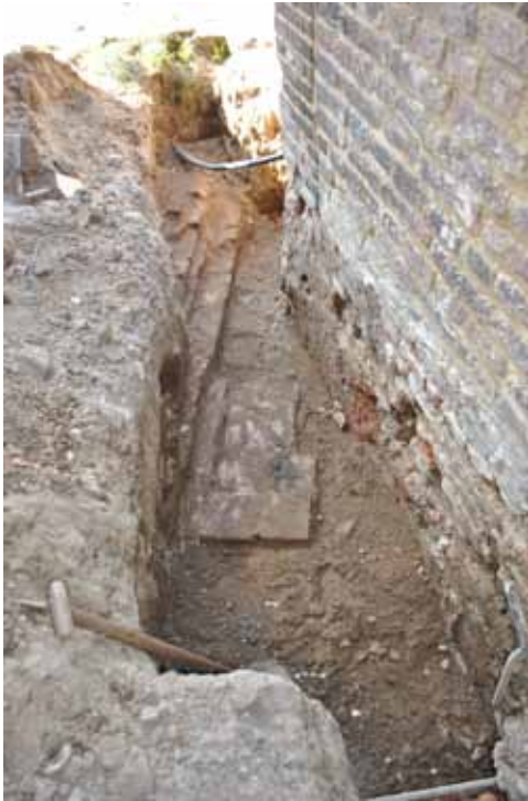
13. Muurwerk van een gemetseld riool tussen de oude kapel en de waterkelder.
