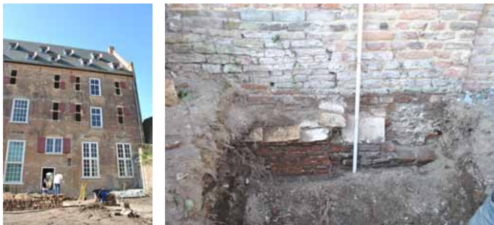
15, 16. Links de achterzijde van het Arsenaal met de locatie van de waarneming ter hoogte van de gele steekwagen, rechts de vindplaats tegen de muur.
