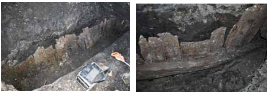
50-52. Beschoeiing van sloopshout. Boven in relatie tot de bestrating, links oostzijde, rechts westzijde met verbindingbalk.
