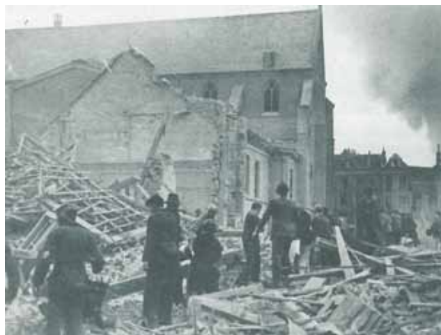
15. Ravage rond de Broederkerk na het bombardement van 14 oktober 1944.
