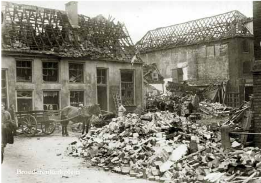
16. Het resultaat van het bombardement van 1944 op de opgravingslocatie. Rechts de voorganger van het pakhuis van Iliohan (zie afbeelding 3). Het totaal ingestorte huis daarnaast bevindt zich exact op de opgravingslocatie. Daarachter een huisje dat aan de Apenstert lag.
