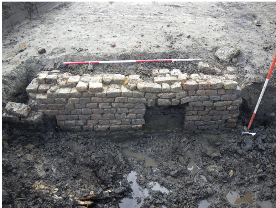
Afbeelding 5.2. Muurtje met rechthoekige uitsparing, opgebouwd uit hele en gebroken stenen (wp 8/s6).
