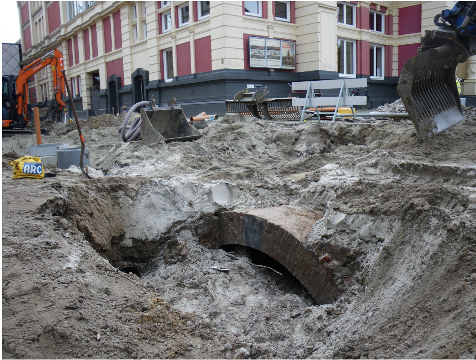
Afbeelding 13. Het brugfundament vlak na de ontdekking, gezien naar het oosten. Op de achtergrond de Stadsschouwburg.
