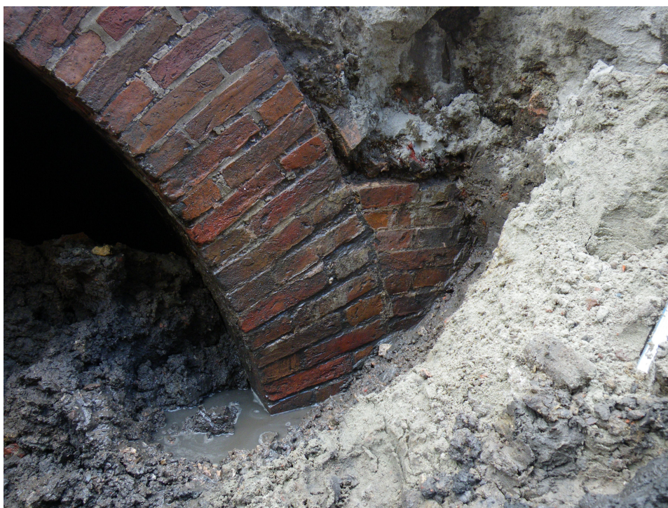
Afbeelding 14. Detail van de brugfundering.
