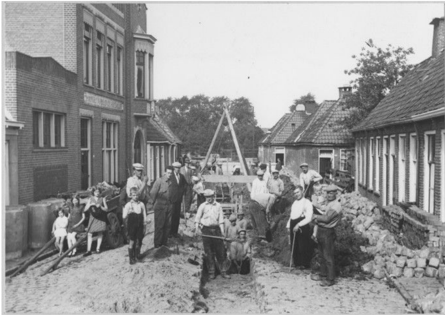
Afbeelding 19. De Walstraat in 1926. Aanleg van het riool. Van de woningen uiterst rechts werd de geheide houten fundering gevonden. Foto: Collectie RHC Groninger Archieven.
