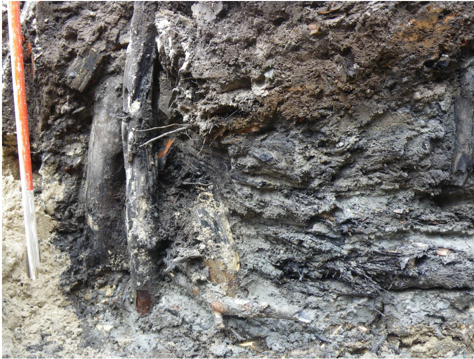
Afbeelding 12. Kruising Kruitlaan/Kruitgracht. Beschoeiingspalen met daarachter gestapelde takkenbossen.
