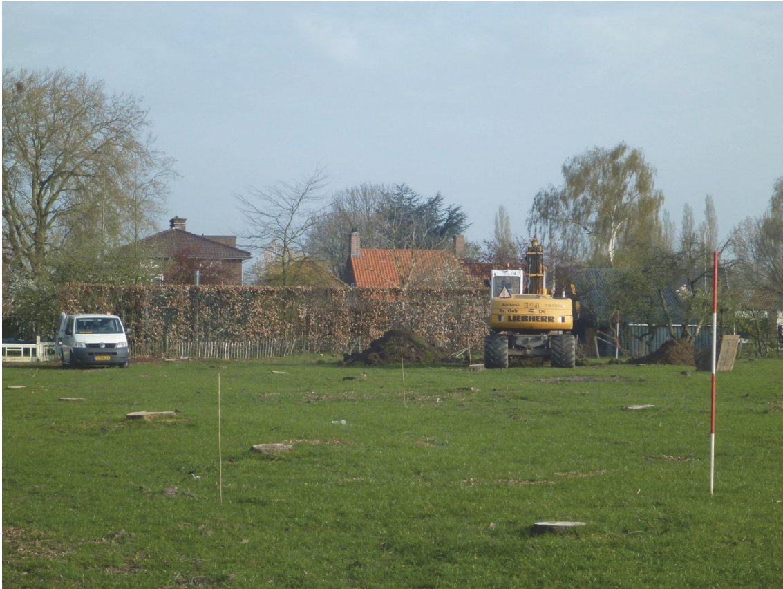
Fig. 1.2: Het onderzoeksgebied bij de aanvang van de werkzaamheden.
