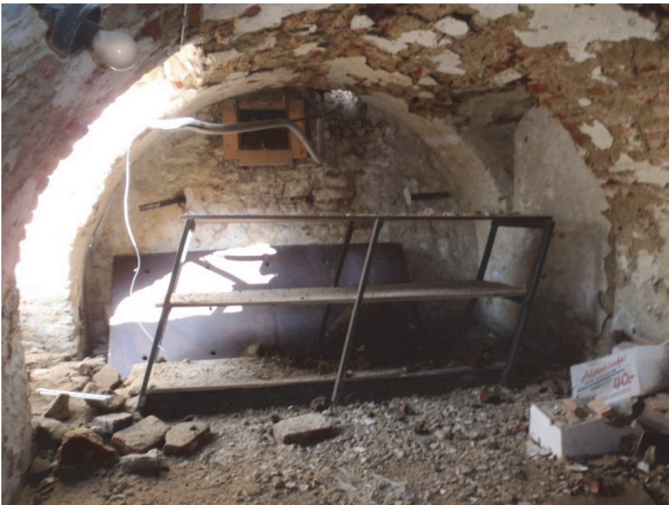
Fig. 5.6: Blik in de kelder van structuur 2 met links moderne ingang en rechts de dichtgemetselde doorgang naar de kelder van structuur 1.
