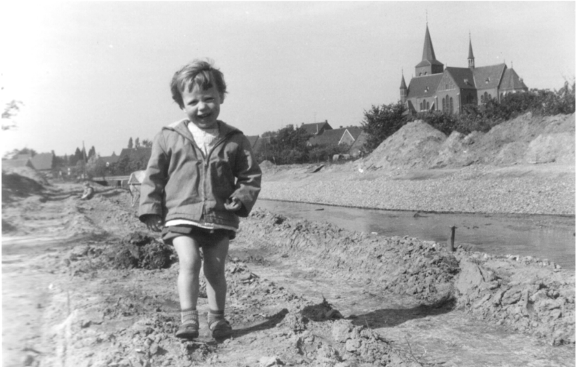
Figuur 19. Graafwerkzaamheden in het kader van verbetering van de waterafvoer in de Tungelroyse Beek in de jaren 60 van 20e eeuw.
