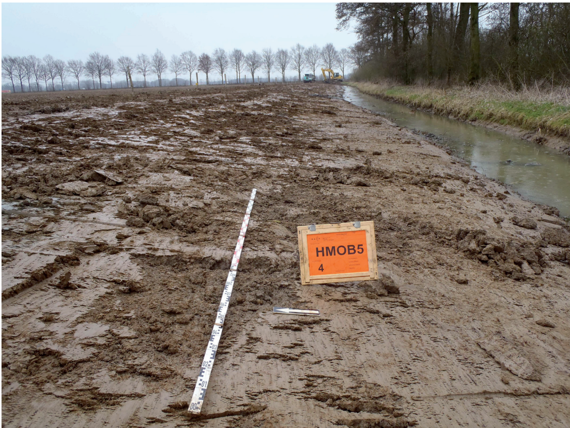
Figuur 3. Impressie van de graafwerkzaamheden.
