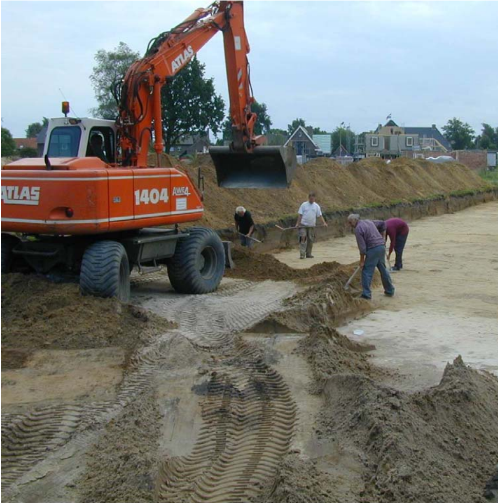
Figuur 3.4 Het aanleggen van de putten
