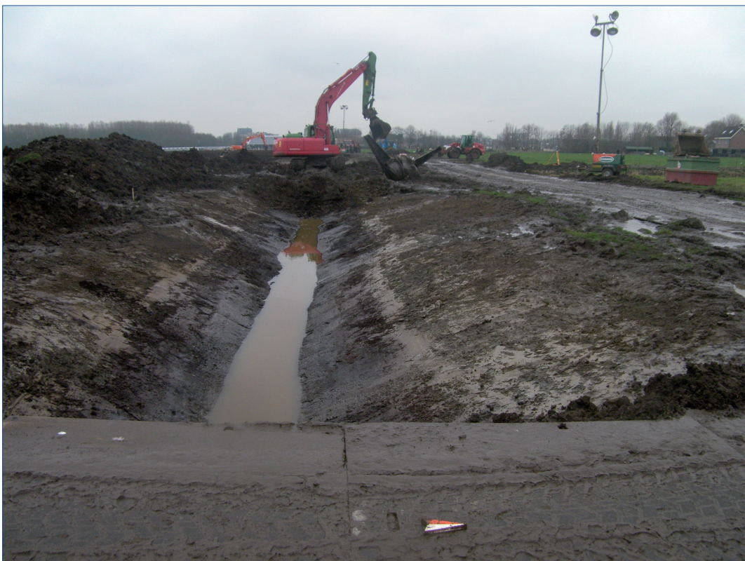
Figuur 8. Impressie schuine profielen door aanleg van de sloten met een vleugelbak in deelgebied B.
