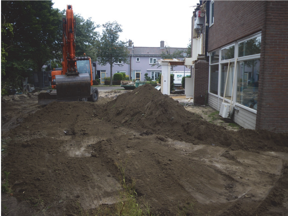
Fig. 4.1: Start van de werkzaamheden.
