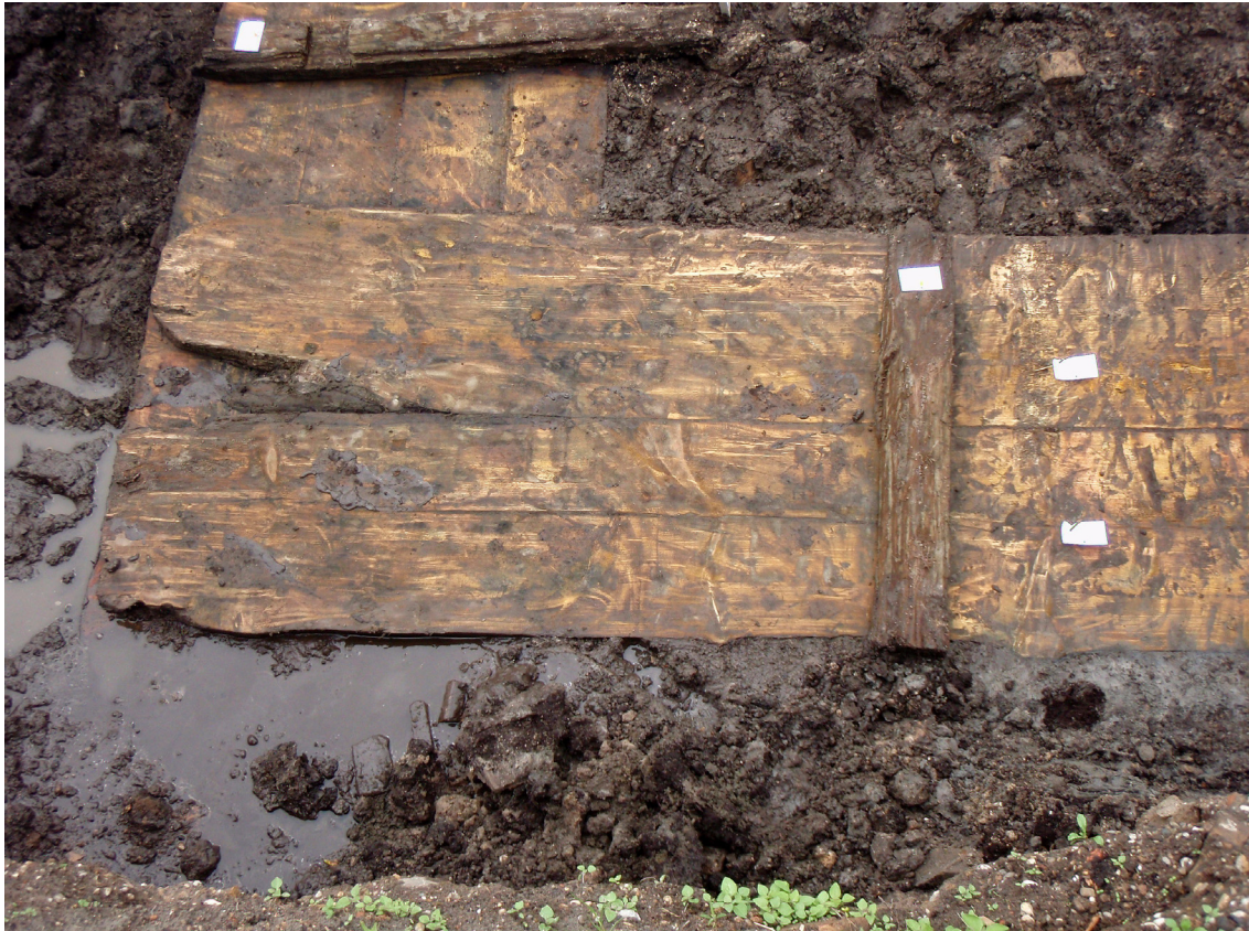
Figuur 30. De planken van het liggend roosterwerk van het hoofgebouw zijn verbonden met ijzeren spijkers.
