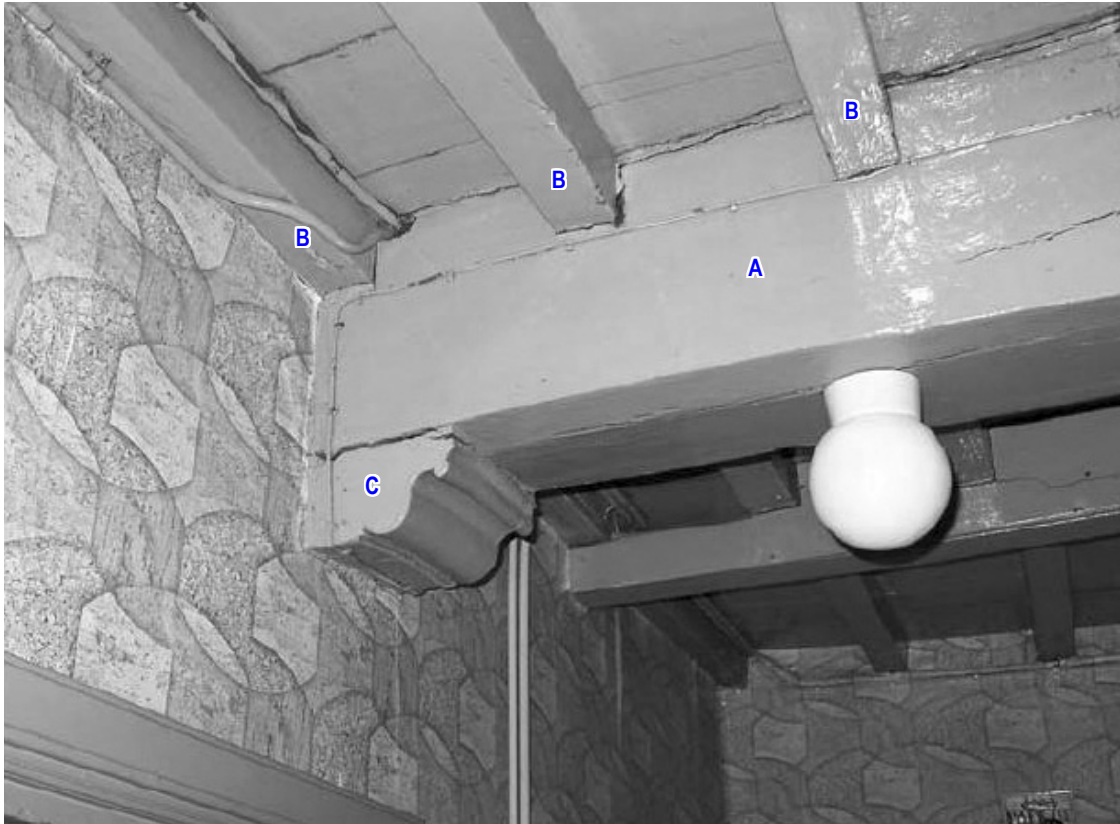
Figuur 6. Op de zware moerbalken (A) liggen de kleine, rechthoekige kinderbinten (B). Deze zijn ingelaten in de moerbalk. De moerbalk wordt ondersteund door consoles met een Renaissanceprofiel (C; bron: Fotoarchief Bureau Helsdingen, Vianen).
