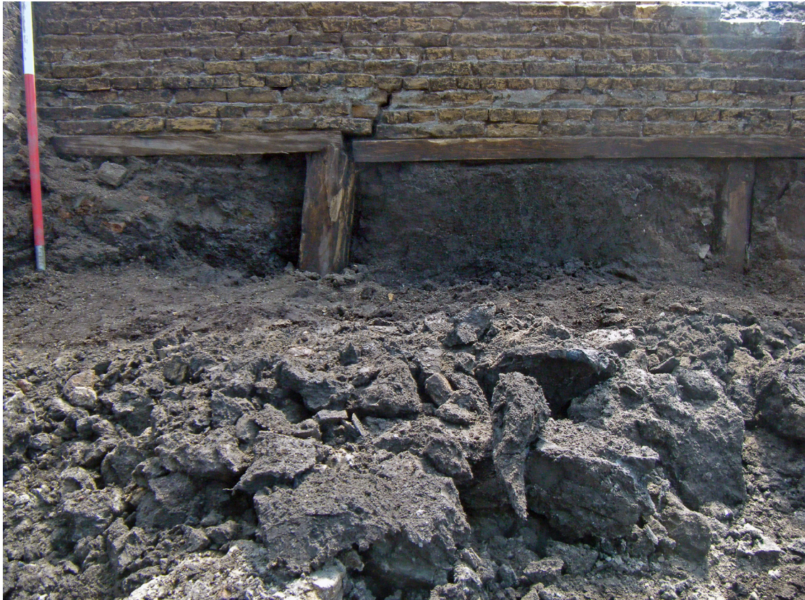
Figuur 39. Fundering gebouw 3 (wagenschuur).
