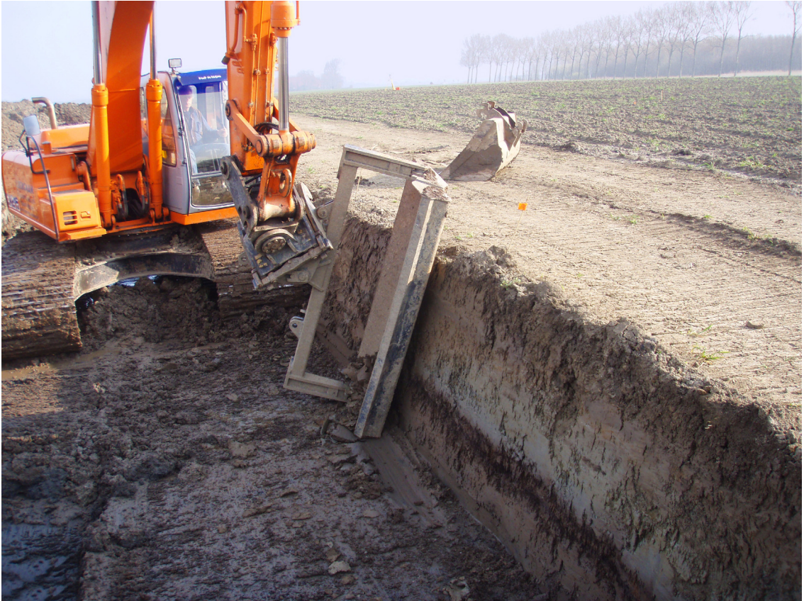
Figuur 4. Het profiel wordt machinaal geschaafd, met een kantelbare schaafbak.
