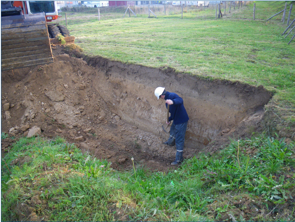
Figuur 1. Het vrijleggen van de oude sleuf.
