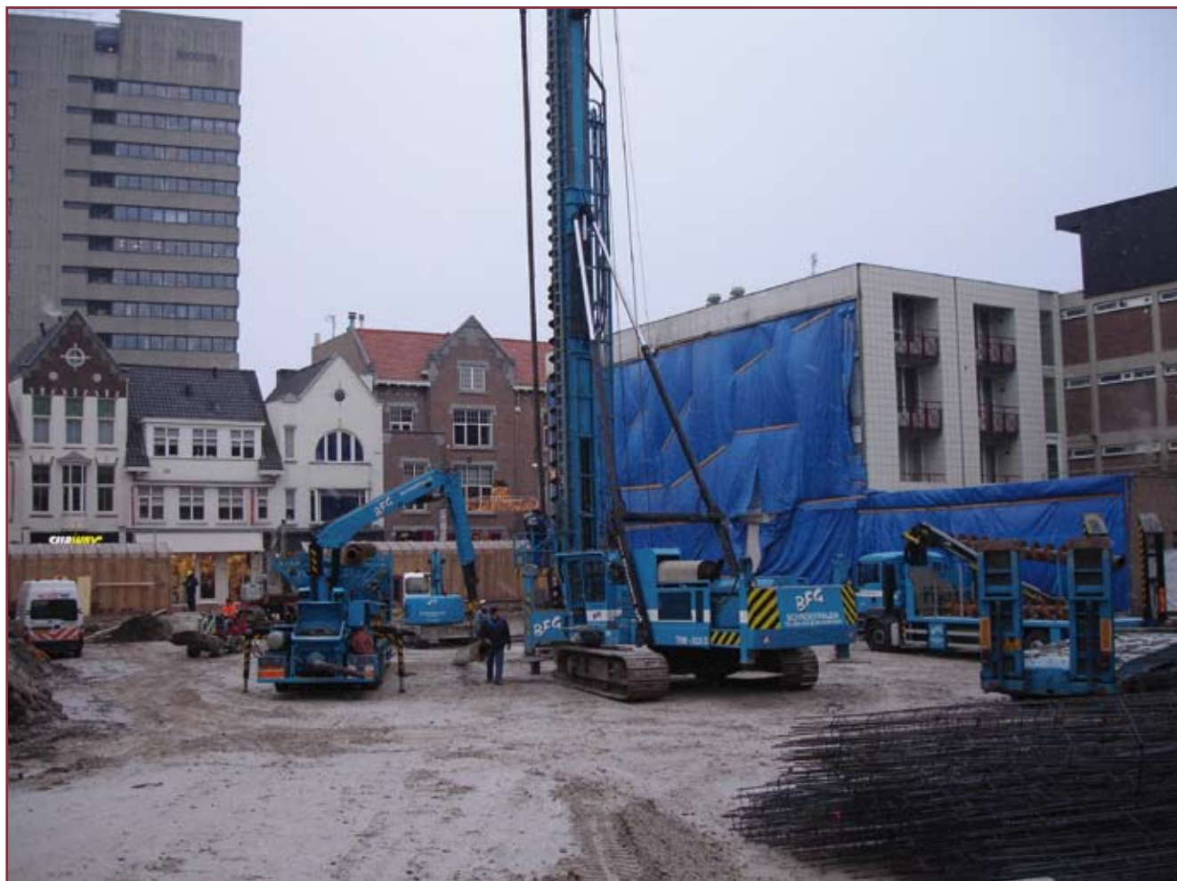
Afbeelding 7. De zware schroefpaalboormachine.
