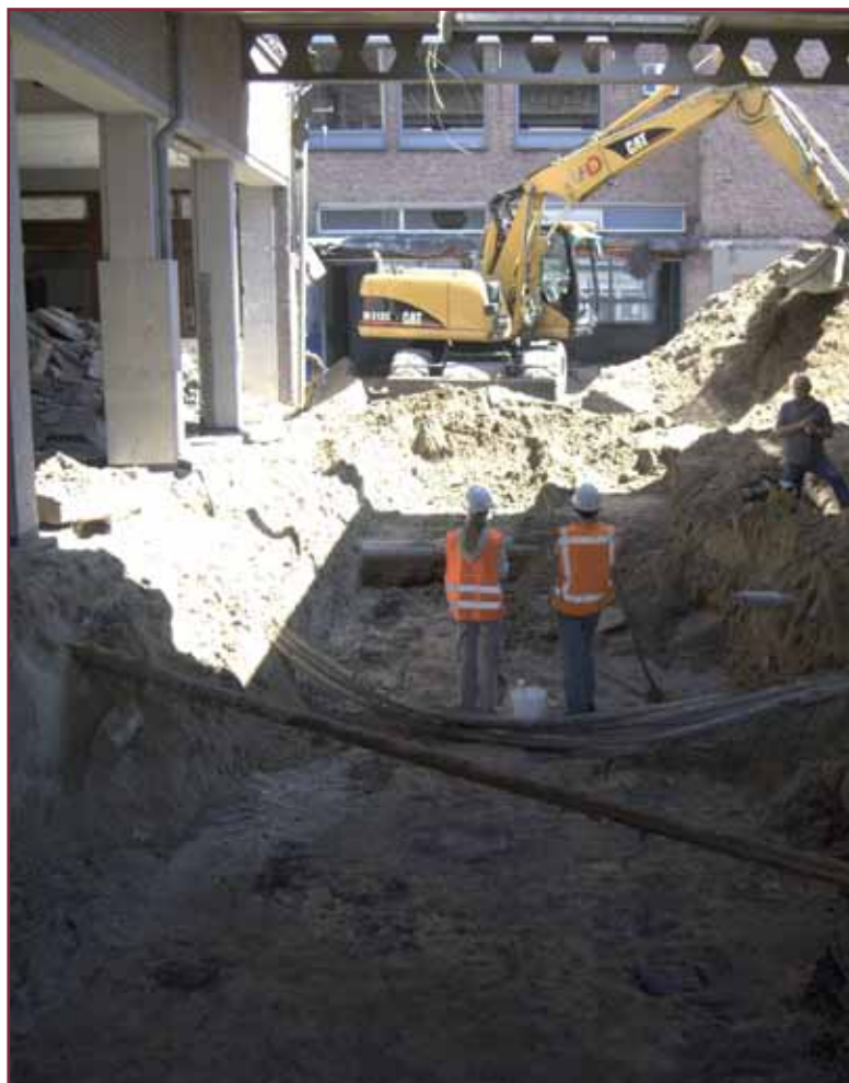
Afbeelding 12. Aanleg van de archeologische werkput. Het uitgraven van de werkput door een graafmachine bleek lastig vanwege de vele nog in de ondergrond aanwezige kabels en leidingen.
