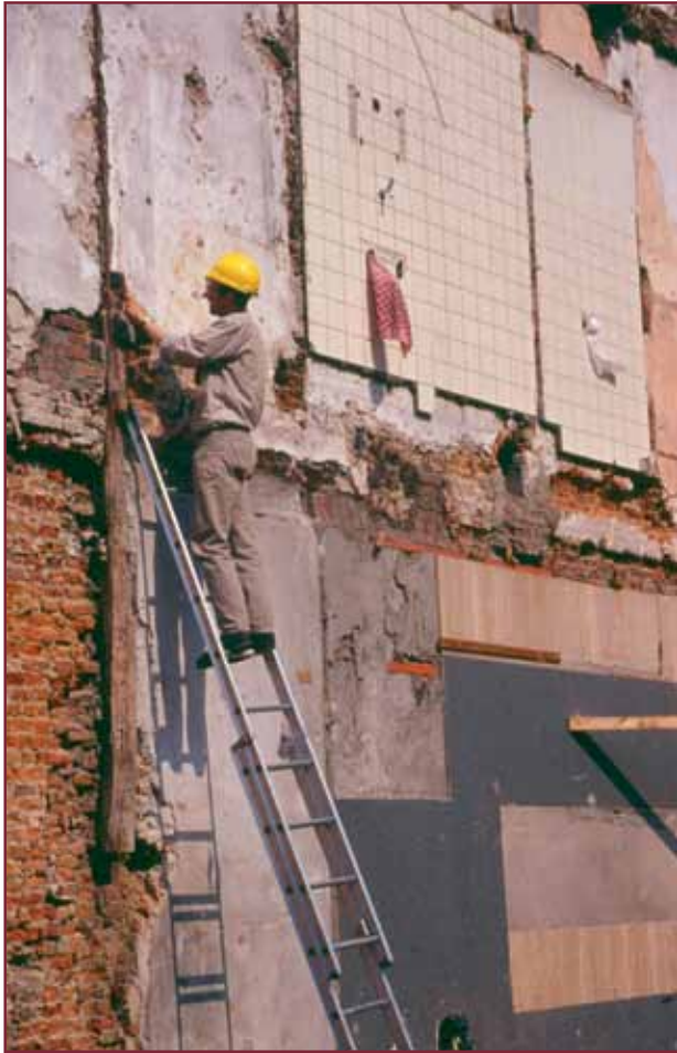
Afbeelding 6. In de zijgevel van Vrijstraat 20 is nog een eikenhouten muurstijl in oud metselwerk aangetroffen. Foto: Theo de Jong.
