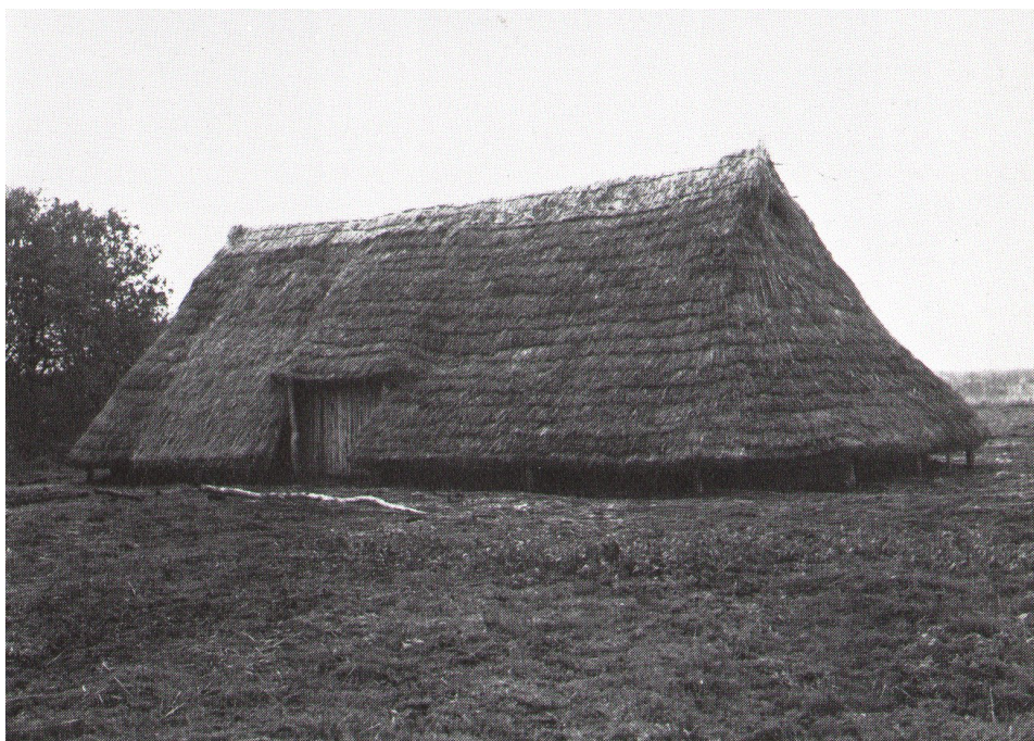
Afbeelding 3.4. Gereconstrueerd huis van het type Hijken in Orvelte. De dakvoetdragende palen zijn duidelijk zichtbaar. Uit: Harsema (1980, p. 29).
