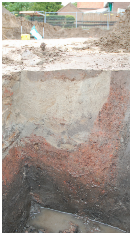
Afbeelding 54. De ingraving van kelder 4 bekleed met een rode gruislaag van baksteen. Vermoedelijk diende dit tegen optrekkend vocht.
