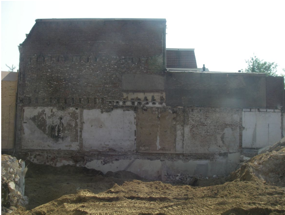
Afbeelding 2.14. Muurwerk van Steenstraat 48, zichtbaar in muurwerk van Steenstraat 46.
