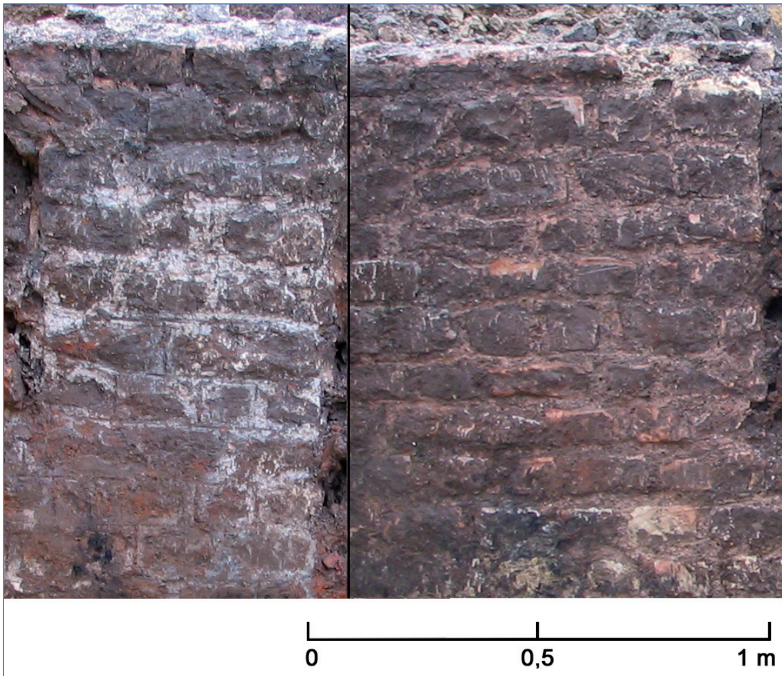
Figuur 6.16. Regelmatig baksteenparement (rechts) en imitatie met ingekraste voegen (links).
