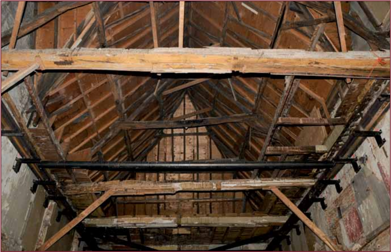
Afbeelding 5. Het 17e-eeuwse zadeldak van het monumentale pand 'Het Schipke' gelegen aan de Vrijstraat te Eindhoven. Ten behoeve van de bouwwerkzaamheden die vóór en na de opgraving plaatsvinden, is de constructie gestut met stalen balken.
