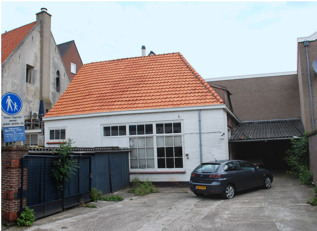
Figuur 2. Bestaande bebouwing op het perceel Academiestraat 3, voorafgaand aan de sloop.
