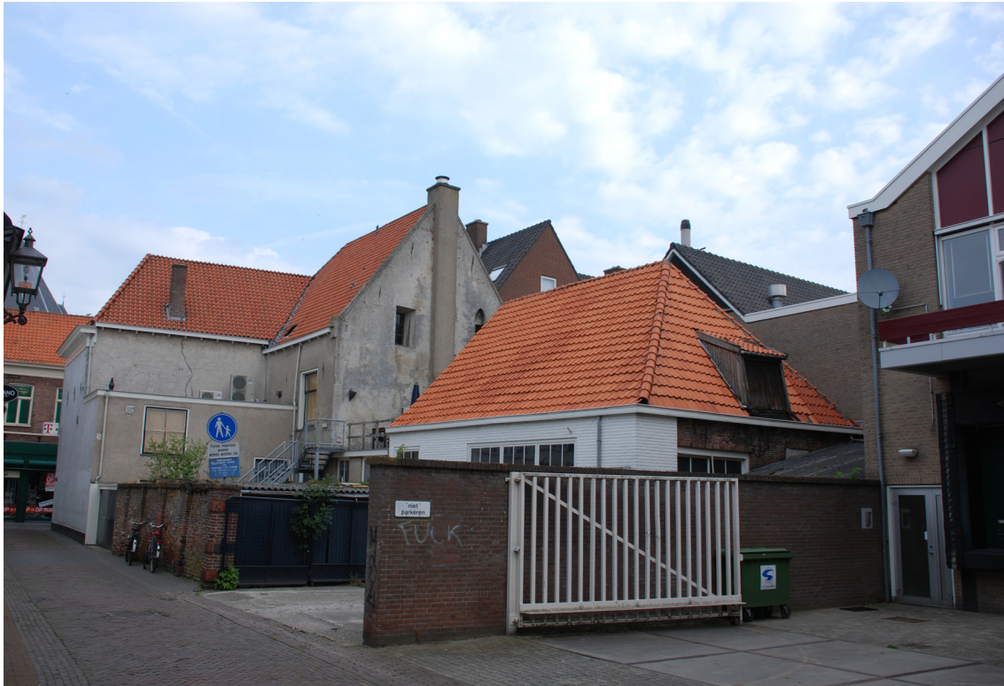
Figuur 29. Bebouwing vlak voor de sloop.
