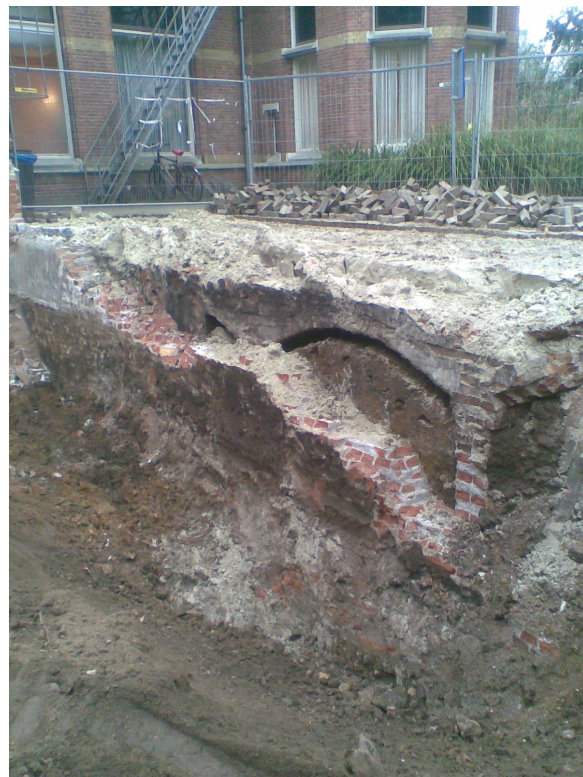
Afbeelding 7. De kelderbogen die na de sloop van de noordwestelijke keldermuur (s11) tevoorschijn kwamen.
