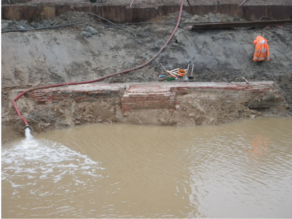
Afbeelding 8. De zuidelijke fundering gezien naar het zuiden.
