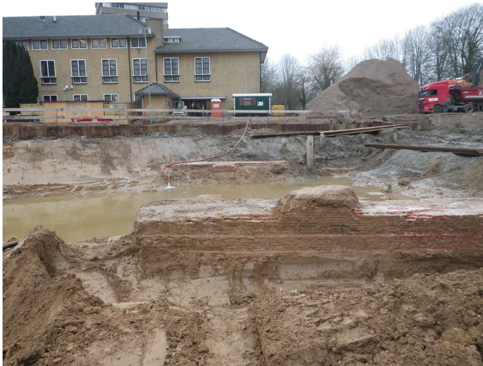
Afbeelding 6. De aangetroffen funderingen van de vestingwerken, gezien naar het zuiden.
