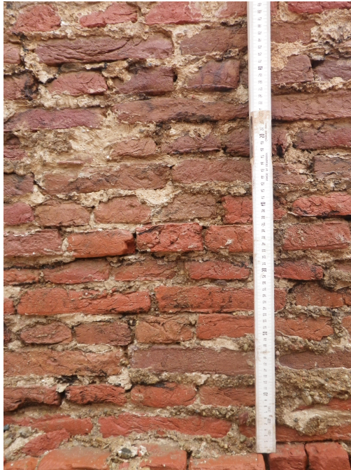
Afbeelding 11. Detail van het metselwerk aan de achterzijde van de noordelijke muur.
