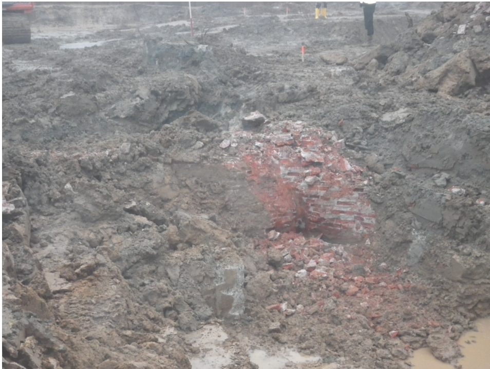
Afbeelding 14. De hoek van de fundering tijdens de sloop.
