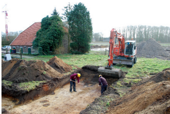
Afb. 5.3 Aanleg van het vlak.
