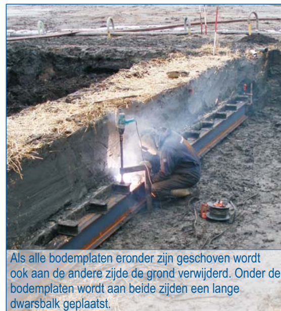
Aan weerszijden van de kano wordt de grond verwijderd, zodat de bekisting kan worden gemaakt. De verwijdering van de grond wordt archeologisch begeleid, in verband met eventuele vondsten zoals bijvoorbeeld fuiken, peddels, gereedschappen.
