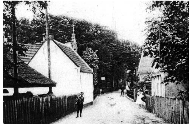
Figuur 7. Het begin van de Dorpsstraat rond 1900. Aan de linkerzijde de hooiberg, de schuur, de gevel van Dorpsstraat 3 en in de verte het uithangbord van het Rechthuys.
