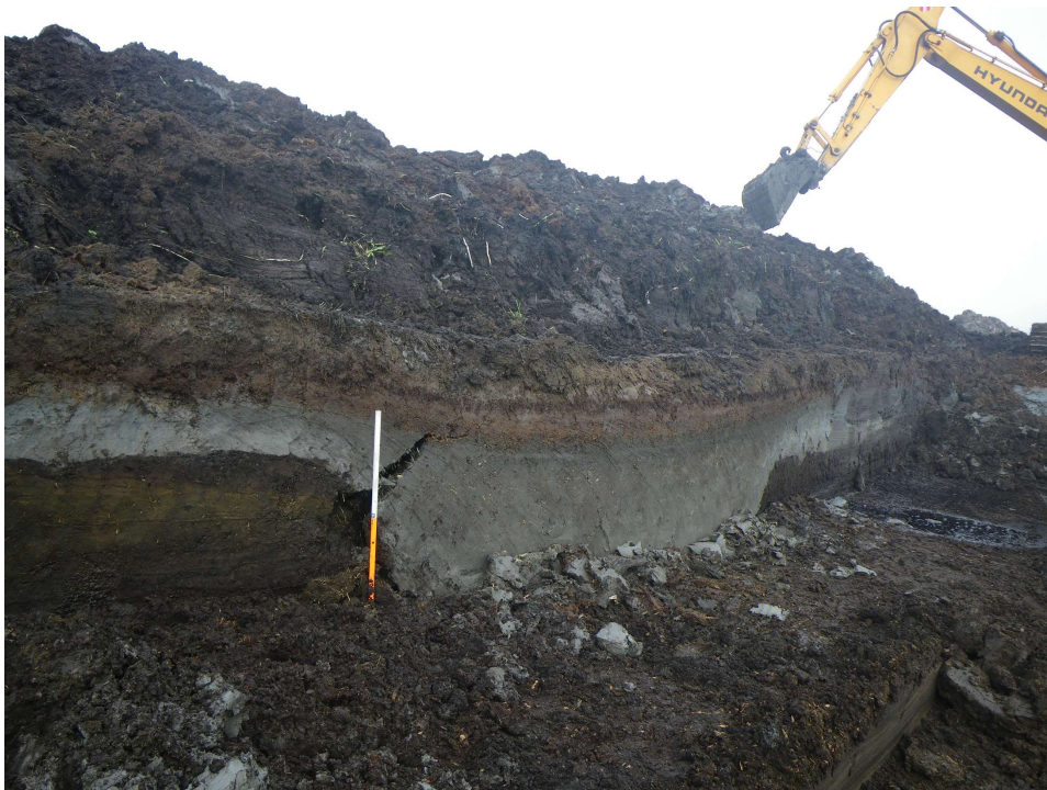
Afbeelding 4. De meest oostelijke sloot in het noordprofiel. Links ervan zijn de terplagen zichtbaar, rechts ervan is alleen nog het natuurlijk veenpakket onder de kwelderafzetting zichtbaar.
