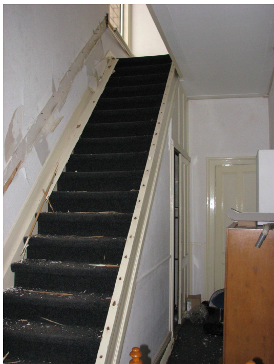
Afbeelding 109 Trappenhuis met trap naar de verdieping. De gaatjes van de balustrade in de boom zijn nog zichtbaar.
