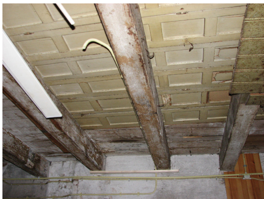
Afbeelding 129 De balklaag van de verdiepingvloer met paneelluiken als vloerdelen.
