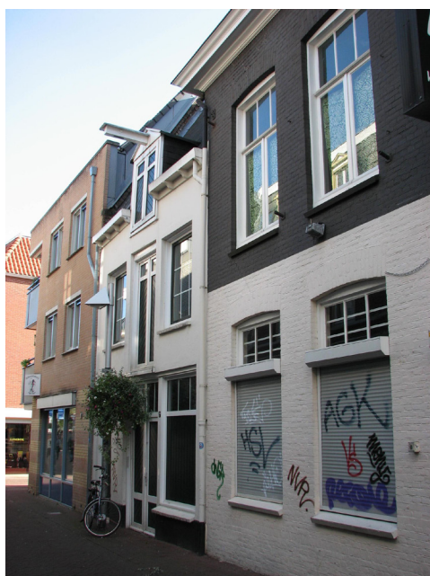
Afbeelding 119 De voorgevel van Klarestraat 2b, enkele weken voor de sloop.
