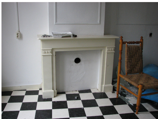
Afbeelding 110 Stookplaats met sobere klassieke schoorsteenmantel op de verdieping tegen de oostwand.
