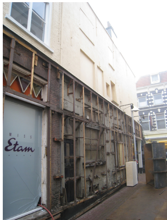
Afbeelding 7 Zijgevel van Koningstraat 17 na verwijdering van de beplating voor de onderbouw.
