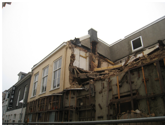
Afbeelding 13 Het achterhuis na sloop van de verdiepingen van Koningstraat 17.
