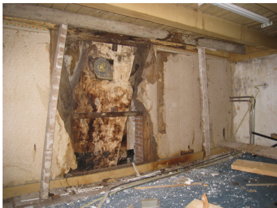
Afbeelding 68 De tweede verdieping richting oostgevel gezien met in het midden een oud rookkanaal.
