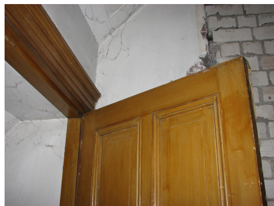
Afbeelding 103 Paneeldeur met houtimitatie van de entree naar de kelder.
