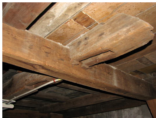
Afbeelding 138 Onderzijde van de hergebruikte grenen dekbalk, dat is ingelaten in de dekbalken van de twee kapebinten, met nog zichtbaar de pengaten voor een jukstijl en korbeel.
