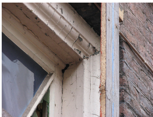
Afbeelding 55 Detail van het bovendeel van één van de kozijnen op de begane grond van de straatgevel van het achterhuis van Koningstraat 17, met de forse ojiefprofielen.
