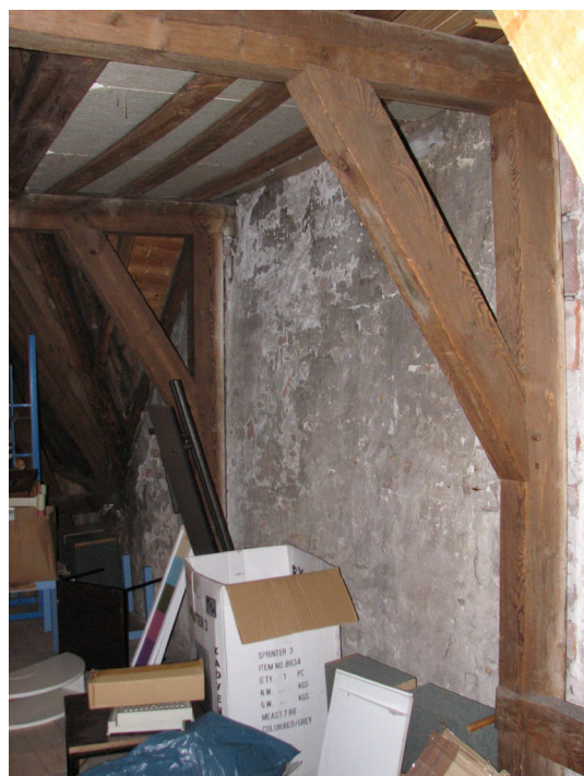
Afbeelding 144 Klarestraat 2b: De twee stijlen met korbelen en dekbalken van de kapgebinten in grenenhout aan de westzijde van het pand.
