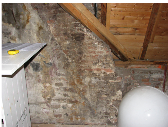
Afbeelding 142 Ophoging in 18 e -eeuwse baksteen aan de achterzijde van de oostelijke zijtopgevel.
