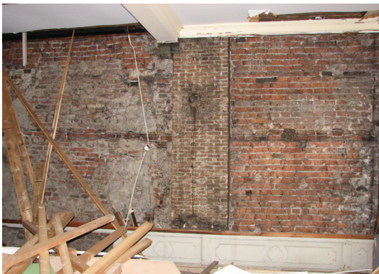
Afbeelding 85 Zicht op de binnenzijde van de rechter zijgevel op de verdieping met rookkanaal, lambrisering en moerbalk met sleutelstuk.
