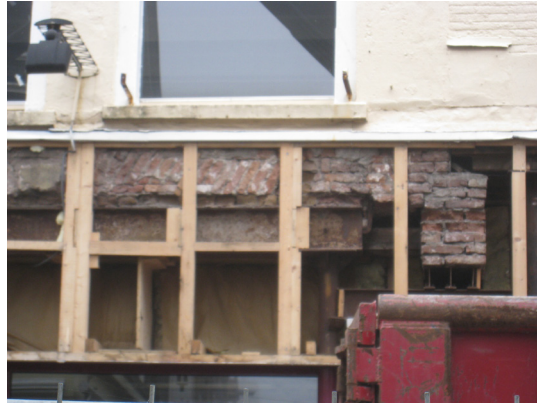
Afbeelding 9 Koningstraat 17, metselwerk met stroomlaag boven pui in voorgevel.
