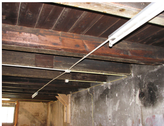
Afbeelding 130 Detail van de zolderbalklaag met ongeprofileerde en geprofileerde balken.
