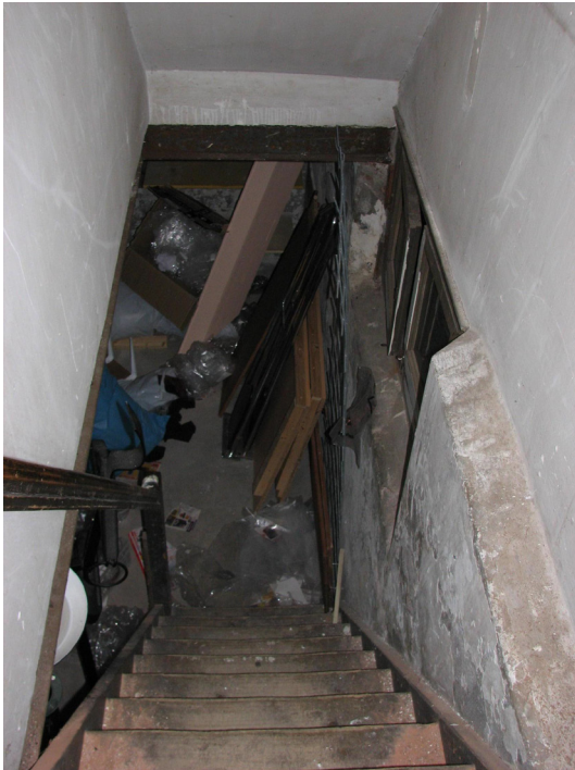
Afbeelding 102 De entree naar de kelder onder het trappenhuis.
