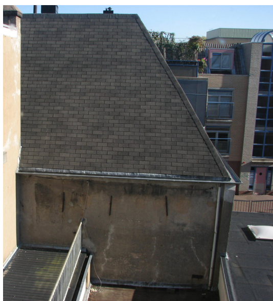
Afbeelding 123 Klarestraat 2b, rechter zijgevel (westgevel) van de achterbouw.
