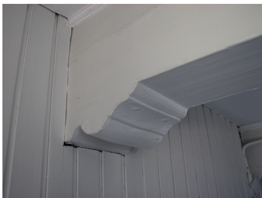
Afbeelding 60 Detail van een balk met sleutelstuk van de enkelvoudige balklaag boven de eerste verdieping van Koningstraat 17.
