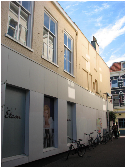
Afbeelding 4 Het hoekpand Koningstraat 17 met achterhuis gezien vanuit de Klarestraat. Het achterhuis, met op de verdieping nog vensters met 6-ruits schuiframen, onderscheidt zich wat betreft gevelindeling duidelijk van de zijgevel van Koningstraat 17.
