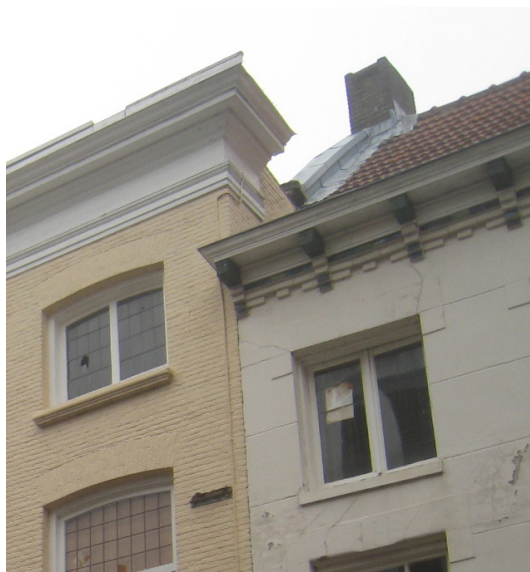
Afbeelding 78 Detail van de aansluiting van de gevels van Koningstraat 18 en 19. Koningstraat 19 betreft een nog betrekkelijk volledig behouden gebleven laat middeleeuw dwarshuis.
