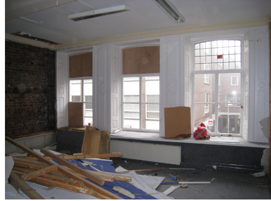
Afbeelding 95 Koningstraat 18, verdieping van het voorhuis gezien richting voorgevel.
