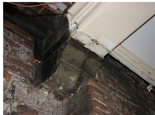
Afbeelding 88 Moerbalk met sleutelstuk van de eerste vrij liggende moerbalk.
