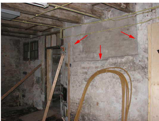
Afbeelding 127 Overzicht van de rechter wand van het achterste deel van de begane grond met rechts van het midden de ondiepe rechthoekige nis (de pijlen geven de begrenzingen aan van dit verdiepte muurvlak).
