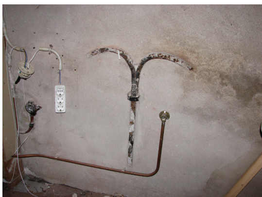
Afbeelding 70 Detail van één van de Y-ankers op de zolder van het achterhuis, links in de gevel.
