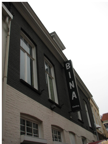
Afbeelding 99 Klarestraat 2a, verdieping van de voorgevel kort voor de sloop.
