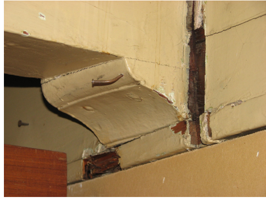
Afbeelding 63 Detail van een balk met sleutelstuk van de zolderbalklaag.
