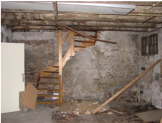
Afbeelding 125 Klarestraat 2b, interieur begane grond gezien richting achtergevel.
