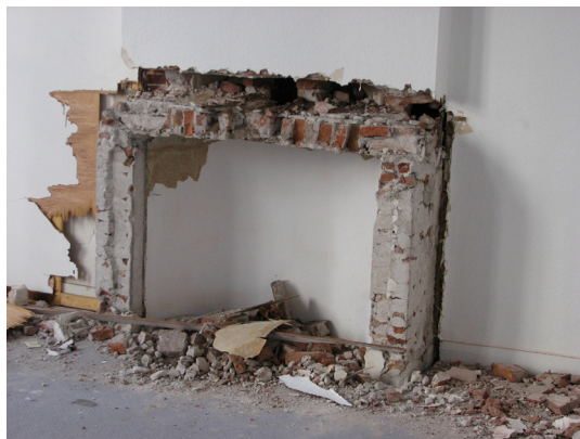
Afbeelding 69 Een restant van de 19 e -eeuwse stookplaats op de verdieping van het achterhuis.
