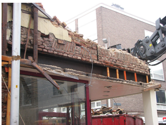
Afbeelding 54 Detail van de tot vrijwel aan de winkelpui gesloopte zijgevel van Koningstraat 17. Direct boven de pui is metselwerk met stroomlagen zichtbaar met daarboven weer oud metselwerk met grotere baksteen.
