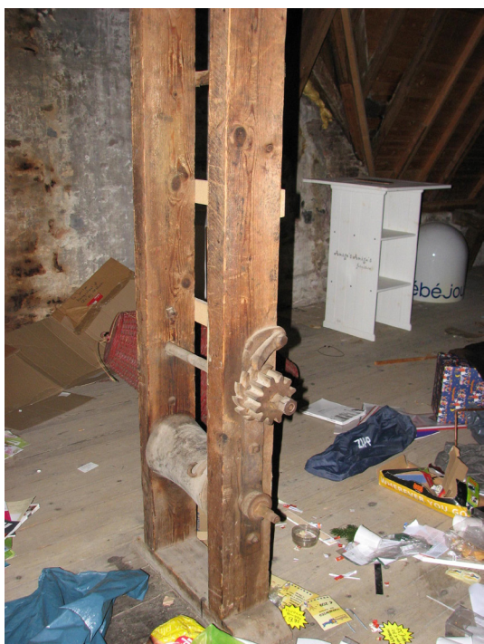
Afbeelding 135 Stijlen met een windas en tandwielen voor het optakelen van goederen via de hijsbalk aan de dakkapel. Deze stijlen sluiten aan op de dekbalk van het noordelijke gebint.
