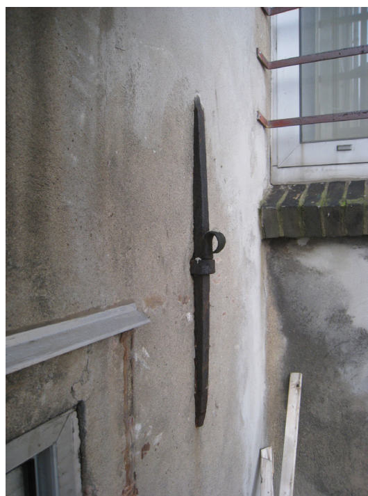
Afbeelding 82 Detail van één van de oude ankers in de achtergevel van het achterhuis.
