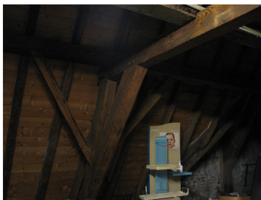
Afbeelding 140 Grenen dekbalkjuk van de achterhuiszolder.
