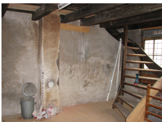
Afbeelding 133 Zicht op de linker wand van de verdieping met rookkanaal.
