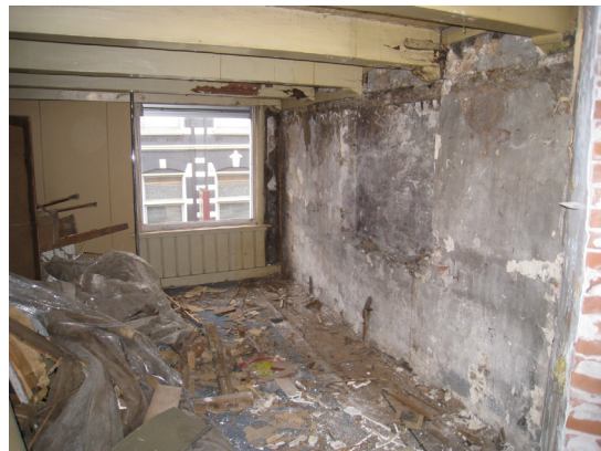
Afbeelding 65 Zicht door de tweede verdieping richting voorgevel.
