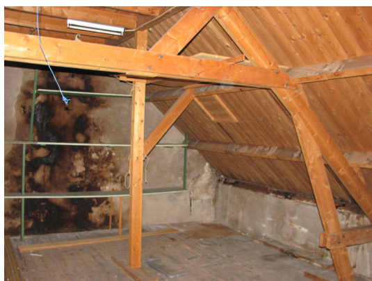
Afbeelding 71 De vroeg 20 e -eeuwse dakconstructie in het achterhuis van Koningstraat 17.
