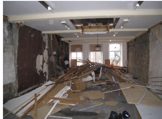
Afbeelding 97 Koningstraat 18, het feitelijke voorhuisgedeelte op de verdieping met in het plafond zichtbaar de moerbalken.
