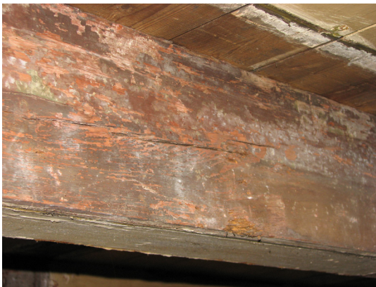
Afbeelding 64 Zicht op een grenen balk van de zolderbalklaag met oude verfsporen.
