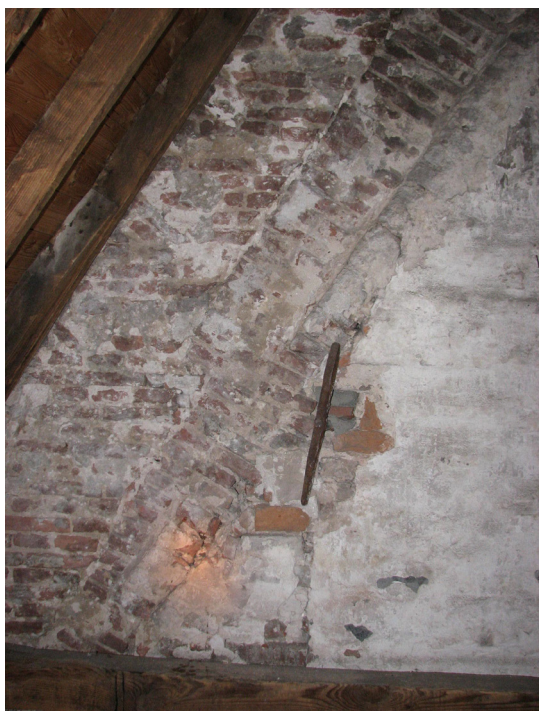
Afbeelding 141 Ophoging met 18 e -eeuwse baksteen van de oostelijke zijtopgevel.
