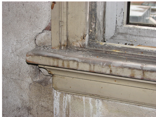
Afbeelding 116 Detail van een zoldervenster in de achtergevel van Klarestraat 2a.
