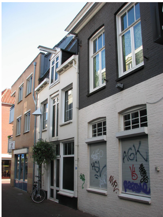
Afbeelding 6 De gepleisterde gevel met als Vlaamse gevel opgezette dakkapel met hijsbalk van Klarestraat 2b. De raaminvullingen zijn van recente datum.
