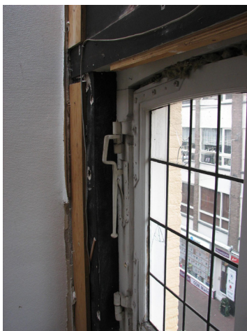
Afbeelding 91 Detail van het rechter zoldervenster met de hefboominstallatie voor het klappraam.
