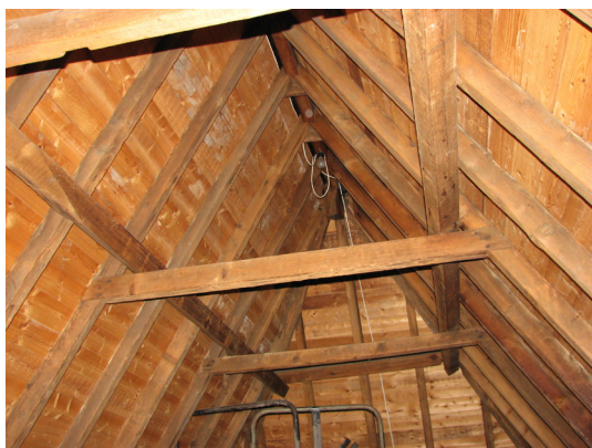
Afbeelding 137 Klarestraat 2b: De nok met haanhouten en gordingen van de achterhuiskap.
