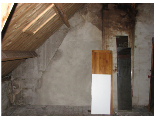
Afbeelding 72 De zolder van het achterhuis gezien richting Klarestraat 2a. Let op de oude daklijn.
