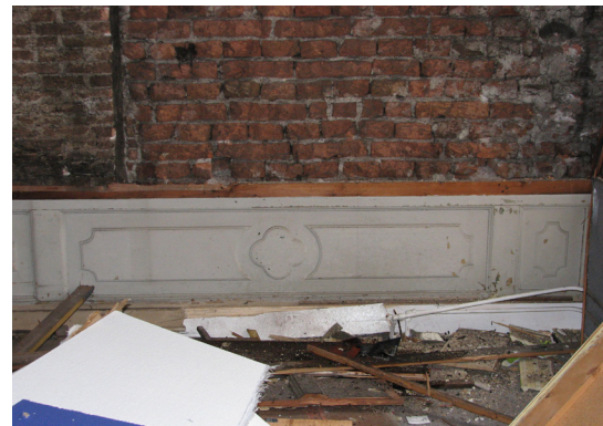
Afbeelding 86 Detail van het middeleeuwse metselwerk met daaronder de lambrisering.
