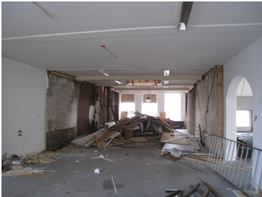
Afbeelding 96 Koningstraat 18, verdieping gezien vanuit het achterhuis.
