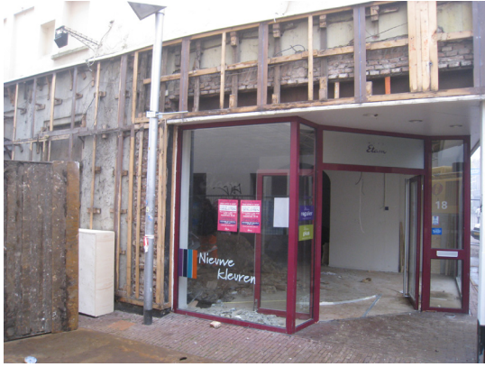
Afbeelding 8 Koningstraat 17, hoek met moderne pui na verwijdering van de beplating.
