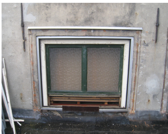
Afbeelding 81 Detail van het linker kozijn met oorspronkelijk 2-ruits bovenlicht.
