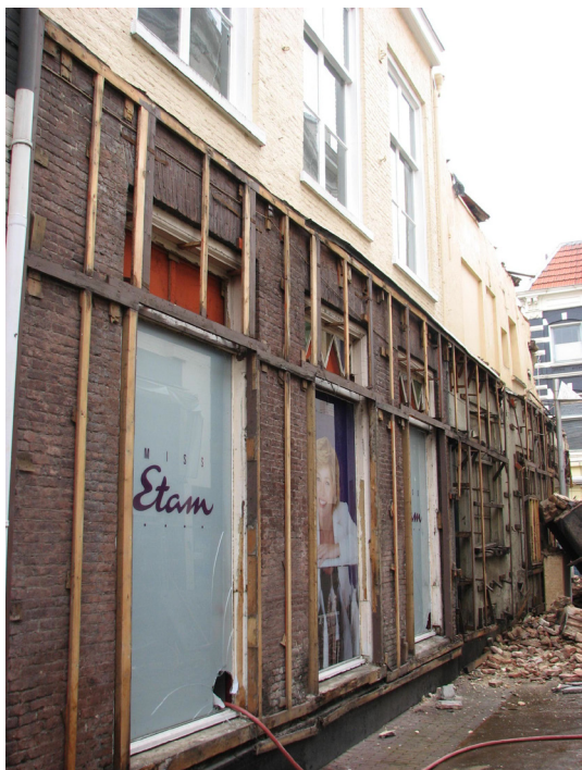
Afbeelding 56 De straatgevel van het achterhuis van Koningstraat 17 na verwijdering van de beplating.
