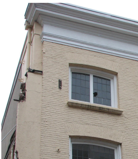
Afbeelding 77 Detail van de linker bovenhoek van de gevel van Koningstraat 18. Let op de aansluiting van de zijgevel en het textuurverschil tussen de gevelsteen en de steen van de vensterbogen! Het metselwerk oogt laat 18 e -eeuws.
