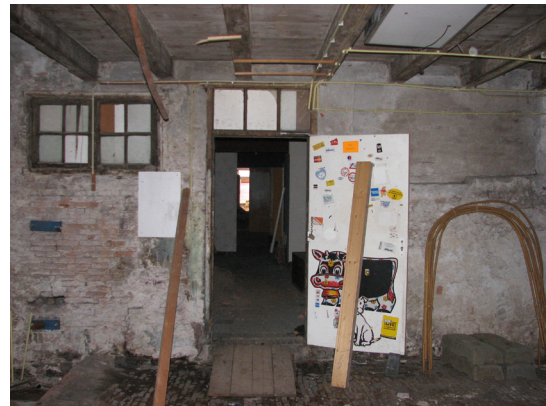
Afbeelding 126 Klarestraat 2b, interieur begane grond, zicht op de rechterwand in het achterste gedeelte.
