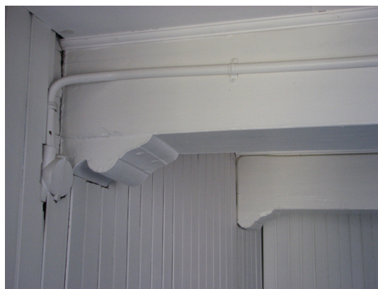
Afbeelding 61 Balken met sleutelstukken aan de westzijde (oplegging in zuidmuur) van de balklaag boven de eerste verdieping in Koningstraat 17.
