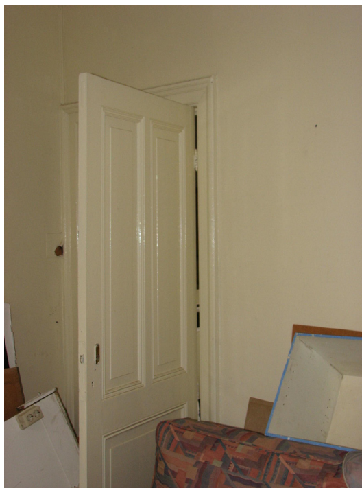
Afbeelding 111 Een 3-vaks paneeldeur op de verdieping. Dit type binnendeur was in het gehele huis toegepast.
