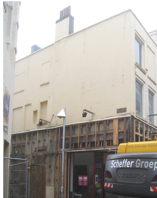
Afbeelding 51 Koningstraat 17, kort voor de sloop. De afplating van de winkelpui was reeds verwijderd.
