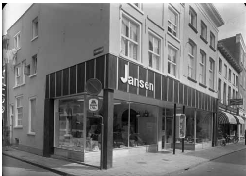
Afbeelding 35 en 36 Foto's uit 1956 van Koningstraat 17 en 18 toen hier nog altijd de winkel van Jansen in was ondergebracht. Beide panden waren samengevoegd, de hellende daken waren verwijderd en er was een nieuwe winkelpui aangebracht (Gemeentearchief Arnhem).
