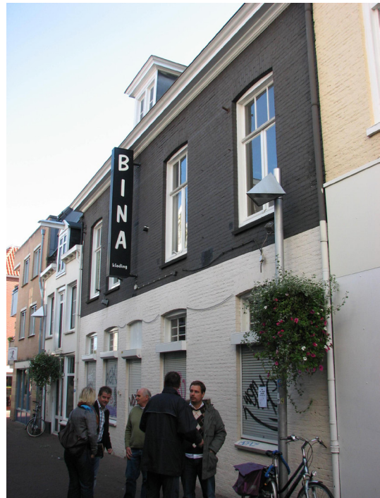
Afbeelding 5 De gevels van Klarestraat 2a (met de donker geverfde tweede bouwlaag) en het lagere Klarestraat 2b met gestucte gevel en dakkapel met hijsbalk.
