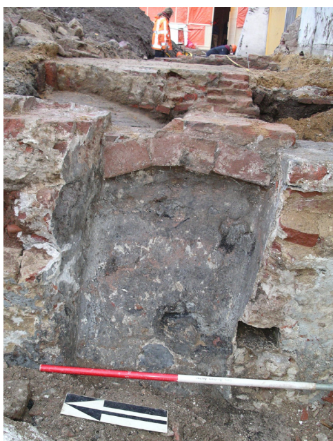
Afbeelding 11 Kelderwand S65 (richting: oost).
