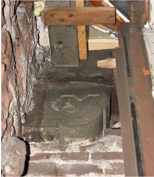
Afbeelding 89 Zicht op de strijkbalk met sleutelstuk met een uitgespaard veld in een Y-patroon op de verdieping in het voorhuis van Koningstraat 18. Het neusstuk met het kwartronde holle profiel is weggezaagd. In de balk daarboven ligt nog een kinderbint.
