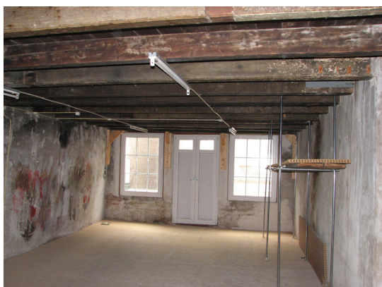
Afbeelding 131 Zicht door de verdieping naar de voorgevel toe.
