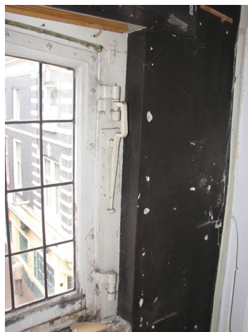
Afbeelding 92 Het linker zoldervenster met de smeedijzeren sluit- en klappconstructie.
