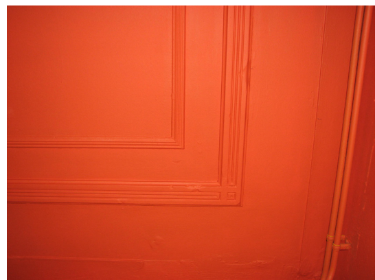
Afbeelding 105 Klarestraat 2a: Detail van de randlijsten van het stucplafond links voor op de begane grond.
