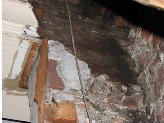
Afbeelding 90 De tweede moerbalk met een ondermetseld sleutelstuk van een vermoedelijk ouder type.
