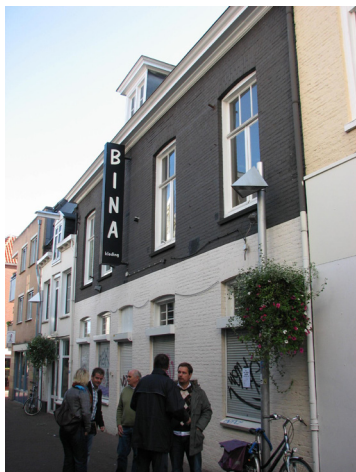
Afbeelding 98 Klarestraat 2a, de voorgevel enige weken voor de sloop. Op de achtergrond de lagere voorgevel van Klarestraat 2b.
