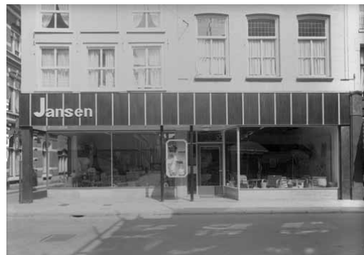
Afbeelding 35 en 36 Foto's uit 1956 van Koningstraat 17 en 18 toen hier nog altijd de winkel van Jansen in was ondergebracht. Beide panden waren samengevoegd, de hellende daken waren verwijderd en er was een nieuwe winkelpui aangebracht (Gemeentearchief Arnhem).
