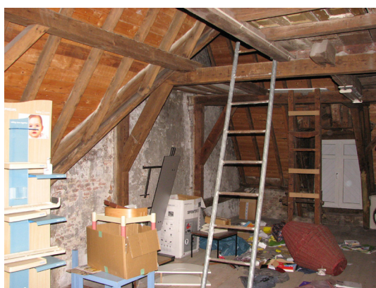
Afbeelding 134 Klarestraat 2b, zicht vanuit de achterzolder naar de voorzolder met de twee gebinten.
