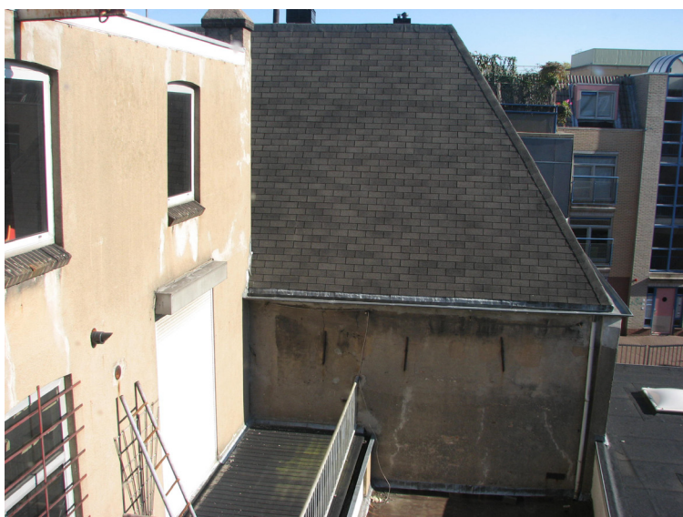
Afbeelding 101 Zicht op een deel van de achtergevel van Klarestraat 2a (links) en de zijgevel en kap van de achterbouw van Klarestraat 2b (midden) vanuit het achterhuis van Koningstraat 18.
