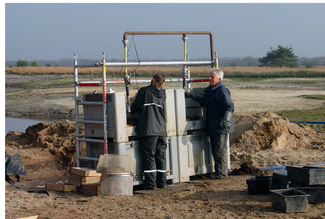
Afb. 13 De zeefinstallatie langs de nieuw uitgraven bedding van de Houtbeek.
