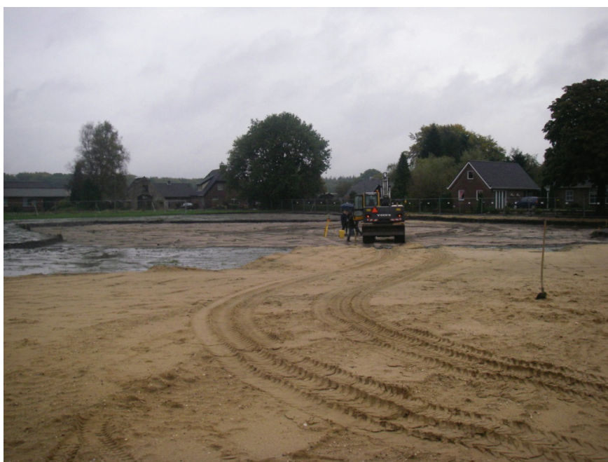
Fig. 1.2: Plangebied bij aanvang van de werkzaamheden.
