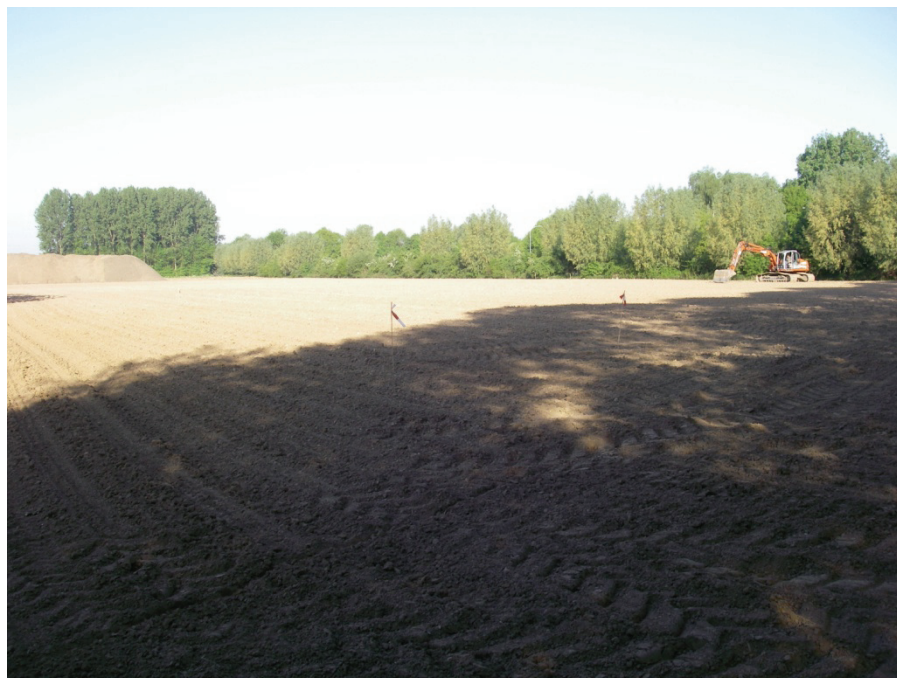
Fig. 1.2: Het plangebied bij aanvang van de werkzaamheden.
