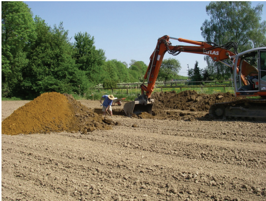
Fig. 4.1: Aanleg van werkput 4 (foto genomen richting het oosten).
