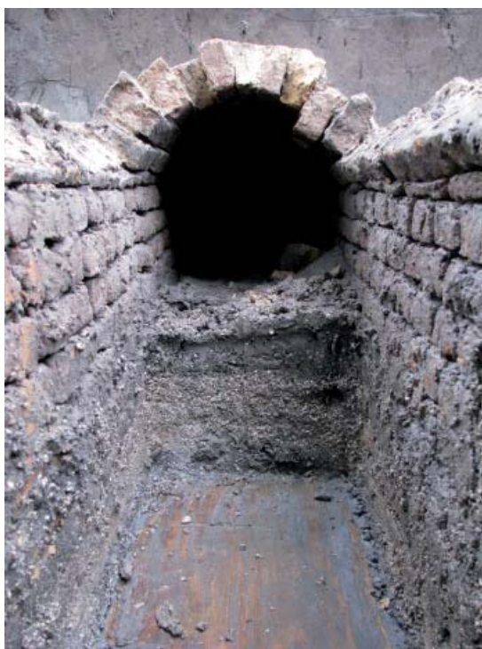
Afbeelding 58. Blik op de binnenkant van de duiker
