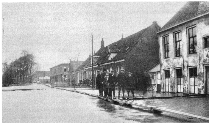
8. Herberg De Vredenberg (het witte pand op de voorgrond) tijdens de overstroming in 1926, vlak voor de afbraak in 1928. Te zien is dat de ramen op grondniveau (in dit geval waterniveau) liggen. Hieraan is af te lezen dat de Emmerikseweg flink is opgehoogd. De omringende huizen uit de periode na 1880 liggen wel hoger. Ook het erf en de bebouwing van Het Houten Wambuis lagen laag ten opzichte van de weg.
