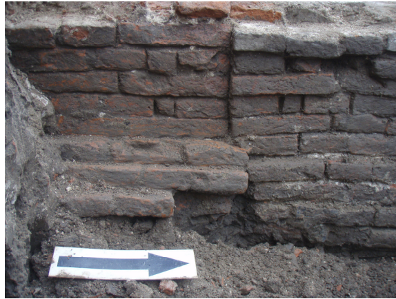
33. Aansluiting van de deel (rechts) op het voorhuis (links). De twee bouwdelen zijn na elkaar gebouwd (koude naad). Voor de hoekoplossing is gebruik gemaakt van klezoren (kwart steentjes).
