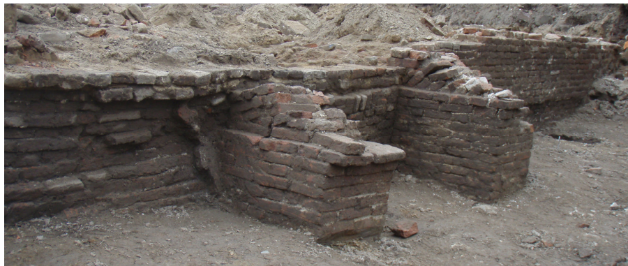
36. De oorspronkelijke deuropening van de deel werd geflankeerd door steunberen. Deze liepen boven het maaiveld schuin naar boven weg. Na ophoging van de terp en de dorpel lagen de steunberen geheel onder het maaiveld.
