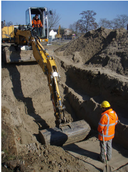
75 en 76. De aanleg van de lange proefsleuf waarin tot grote diepte slechts het opgespoten zand werd waargenomen. Op regelmatige afstand werden extra diepe kijkgaten tot ver in het grondwater uitgegraven, die vervolgens wegens instortingsgevaar direct weer werden gedicht.
