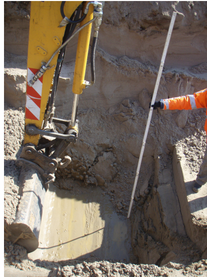
75 en 76. De aanleg van de lange proefsleuf waarin tot grote diepte slechts het opgespoten zand werd waargenomen. Op regelmatige afstand werden extra diepe kijkgaten tot ver in het grondwater uitgegraven, die vervolgens wegens instortingsgevaar direct weer werden gedicht.
